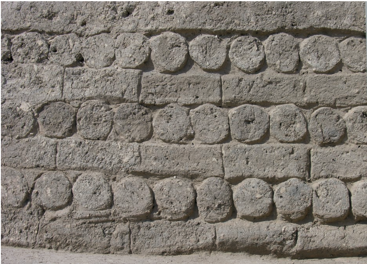
fig. 1 Fondations en briques cruées de forme cylindrique. © Mission franco-égyptienne de Tell el-Herr.
