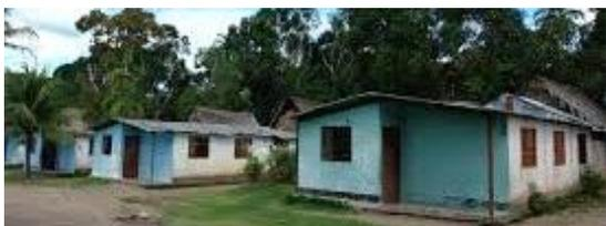
Modelo único de las viviendas rurales de Malariología, de bloque arena-cemento, zinc y estructura metálica – MSAS
