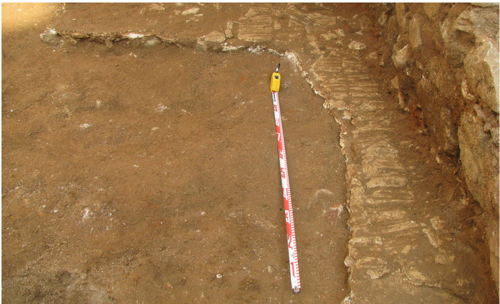
Figura 8. Techo desplomado sobre el pavimento del atrio (E. Medina y R. Pou, 2010).
