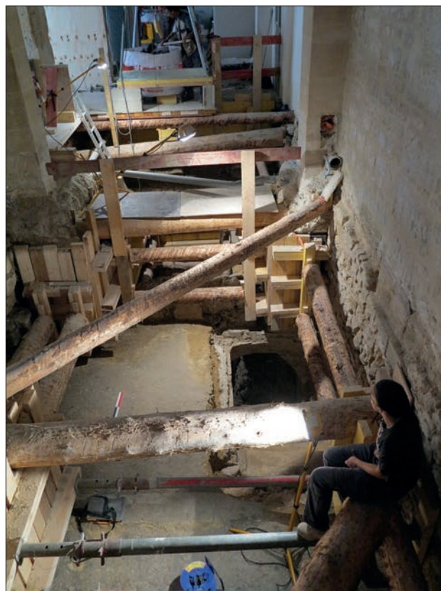
Fig. 13 Méthodologie d'intervention lors de la phase 1 : dispositifs de confortement.
