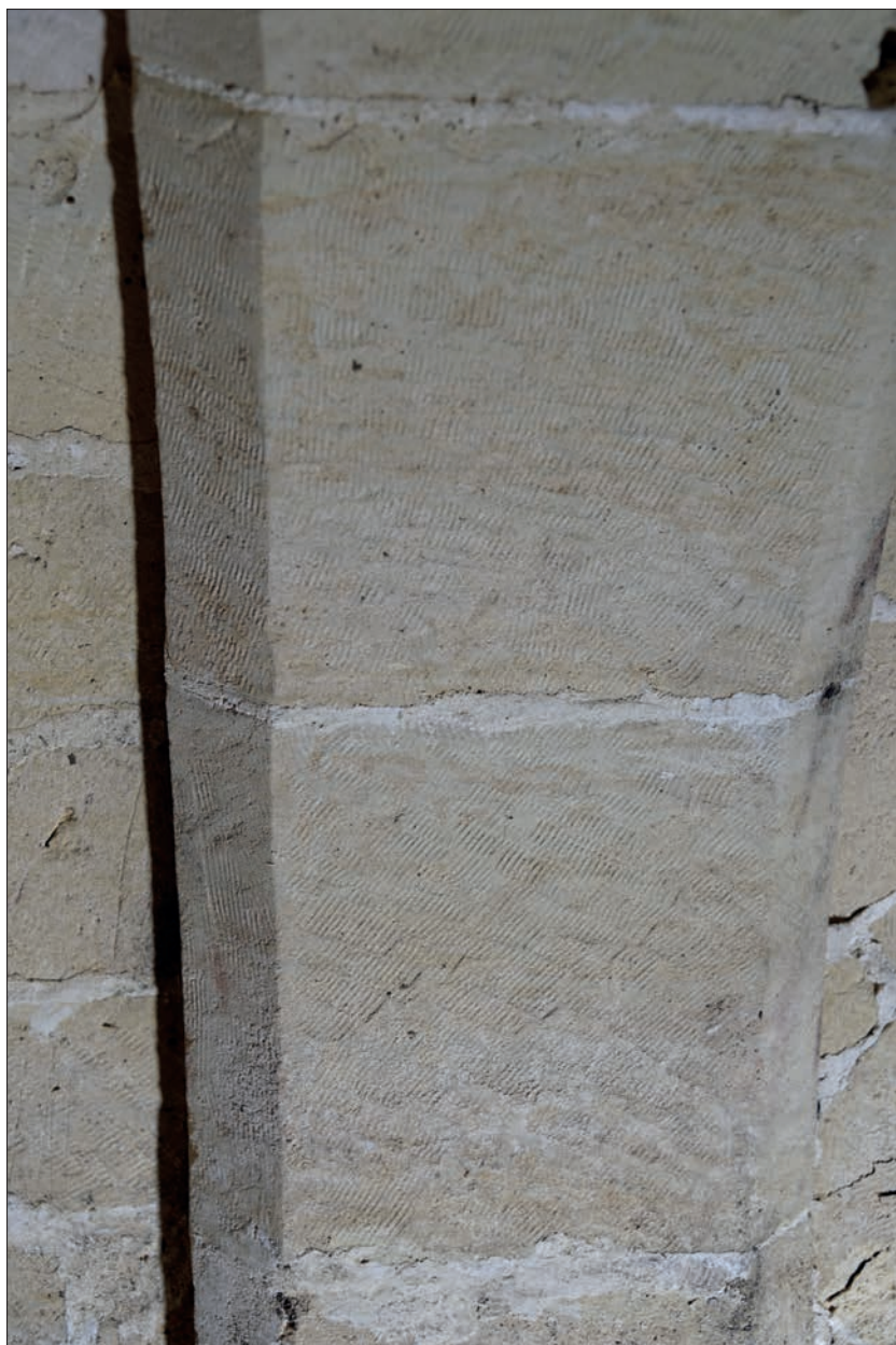
Fig. 101 Détail de l'arc chanfreiné dans la salle 2. Cliché P. Sausserau (DHAAAP/ville de Paris).
