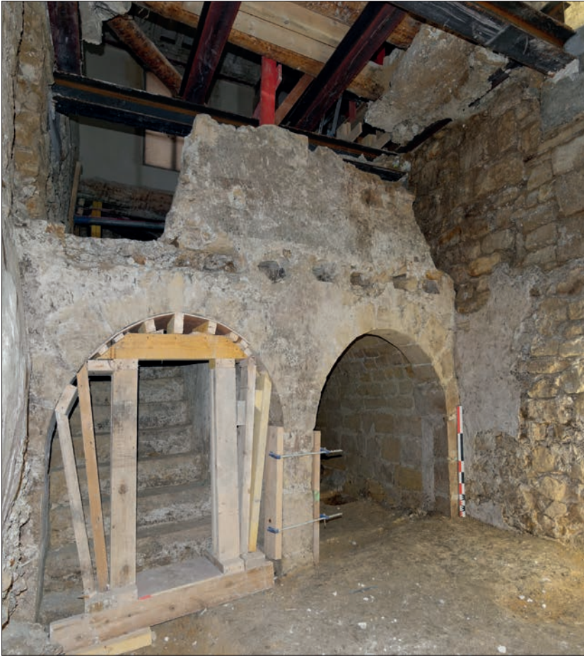
Fig. 17 Les travaux de confortement et de sécurité : IPN métalliques, menuiseries et treuil mécanique.
