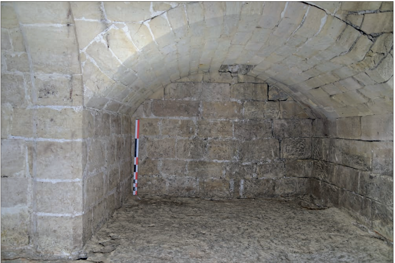
Fig. 97 Vue de la salle 3. Cliché P. Saussereau (DHAAP/ville de Paris).
