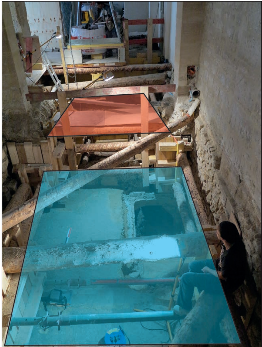
Fig. 12 Vue du chantier en cours avec les butons. En rouge, l'emplacement du puits blindé, en bleu celui de la cave voûtée. Cliché J. Avinain / Ville de Paris.
