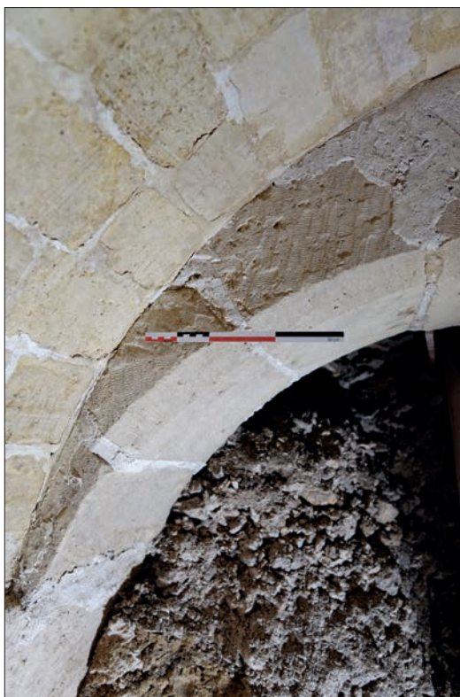
Fig. 102 Détail de l'arc chanfreiné du mur 1042 entre les salles 1 et 2.
