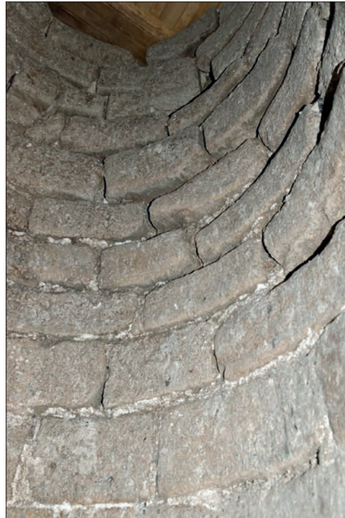
Fig. 93 Vue du parement du puits depuis l'intérieur. Cliché : H. Labit (DHAAP/ville de Paris).
