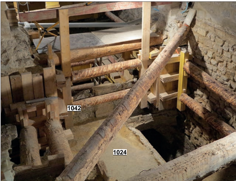
Fig. 78 Le sol 1024 et la maçonnerie 1042. Cliché J. Avinaïn (DHAAP/ville de Paris).
