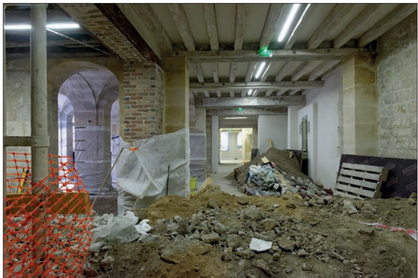
Fig. 5. Vue des anciennes écuries (espace sous plancher) et de la remise à carrosses (voutes en pierres de taille). Cliché Pascal Saussereau, DHAAP
