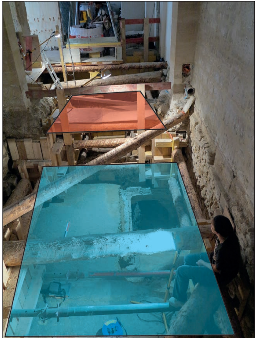
Fig. 12 Vue du chantier en cours avec les butons. En rouge, l'emplacement du puits blindé, en bleu celui de la cave voûtée.
