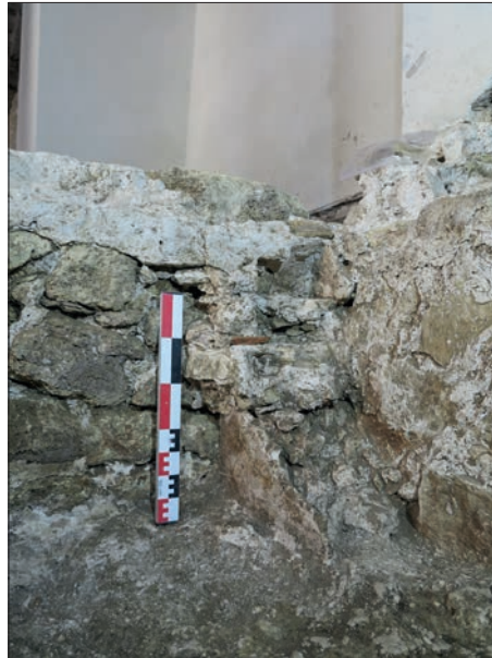
Fig. 125 La maçonnerie 2021 à l'angle de 1011 et 2038.
