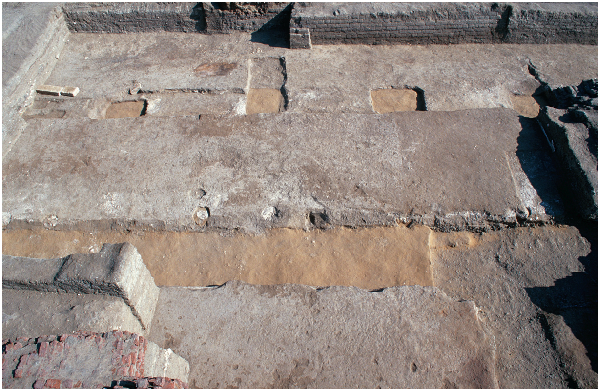
Fig. 42. Portique à colonnade 100A, pendant la fouille. Au premier plan, le sol de la pièce principale (100C), encore en partie recouvert par des constructions appartenant à des phases plus récentes. Notons le remplissage sableux de la tranchée de fondation du mur en pierre calcaire et celui des fondations des colonnes du portique (vue vers le nord)
