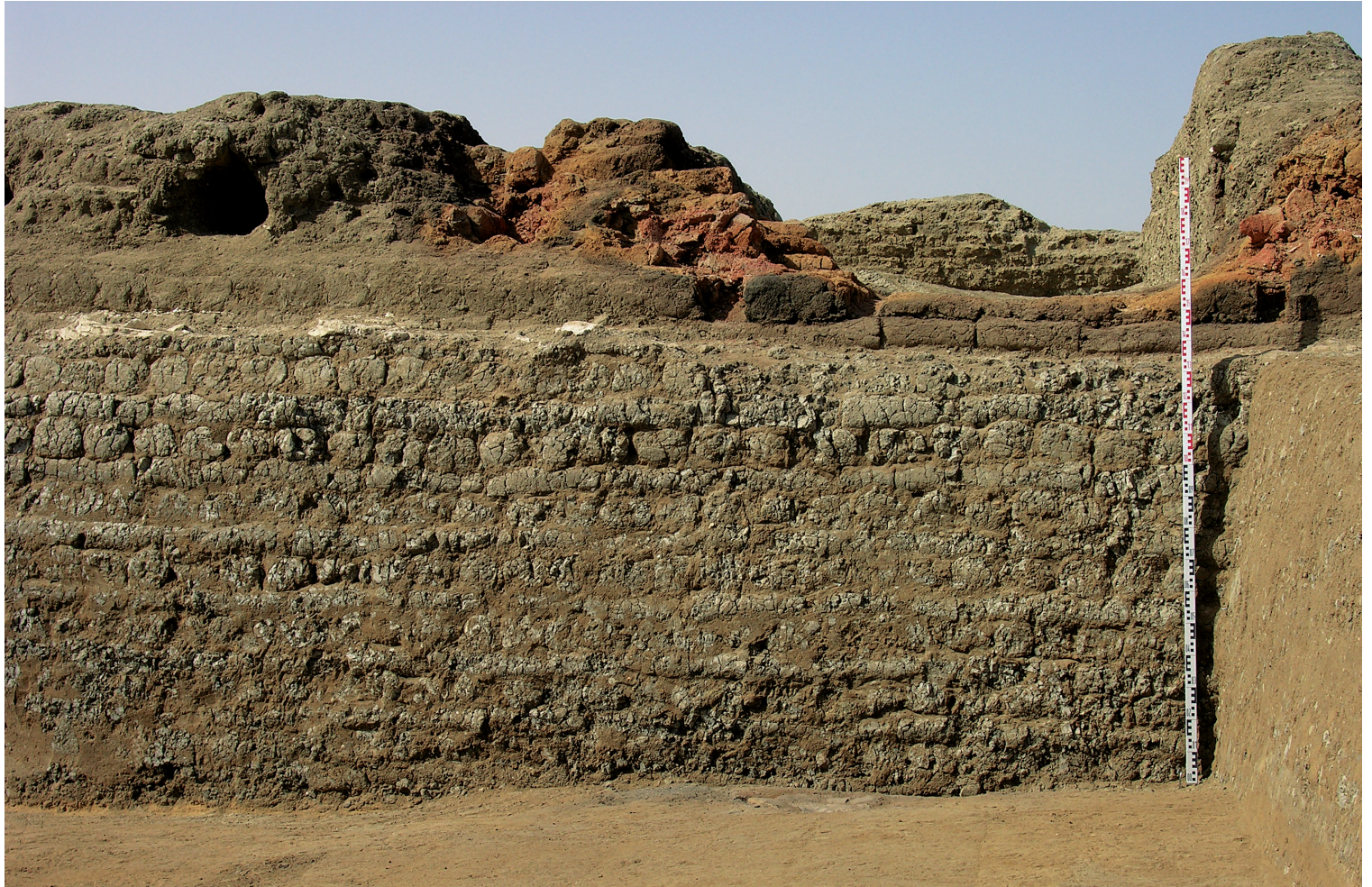
Fig. 29. Briques cylindriques argileuses et assez grossières, employées dans les fondations des murs (ici celles du mur sud de la salle principale 100C)
