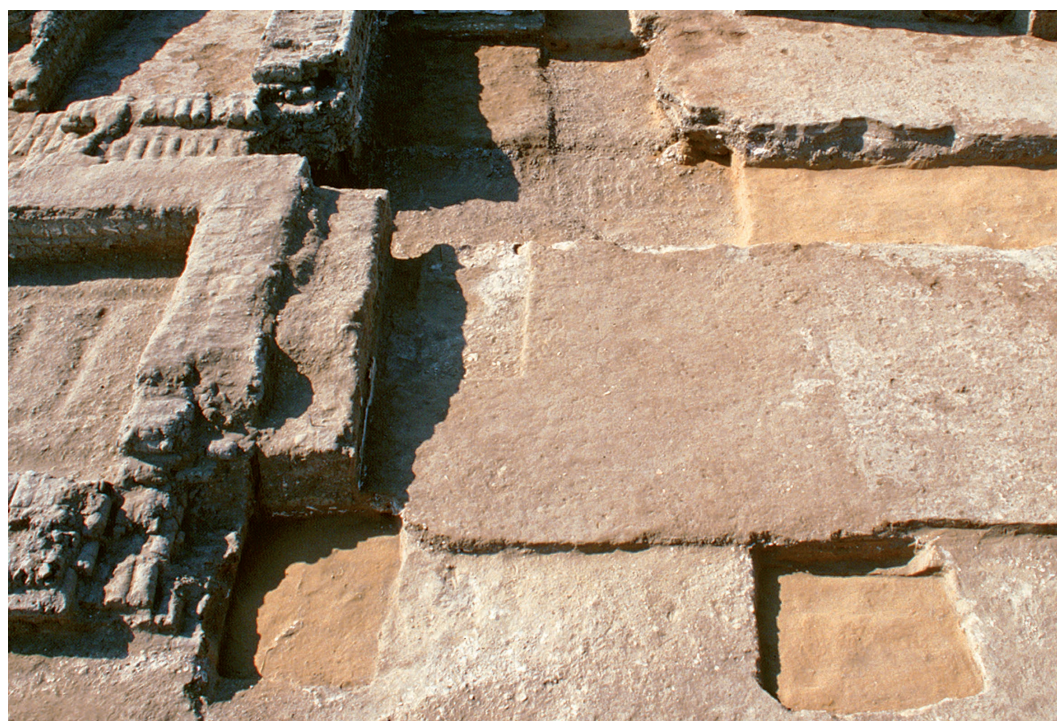
Fig. 46. Fosses de fondations de la première et de la deuxième colonne à l'extrémité est du portique : la fosse de la première colonne (comme celle de la dernière, à l'extrémité opposée du portique) est prévue pour une pierre de fondation plus grande et débordé ainsi vers le sud l'alignement des autres fosses (vue vers le sud)
