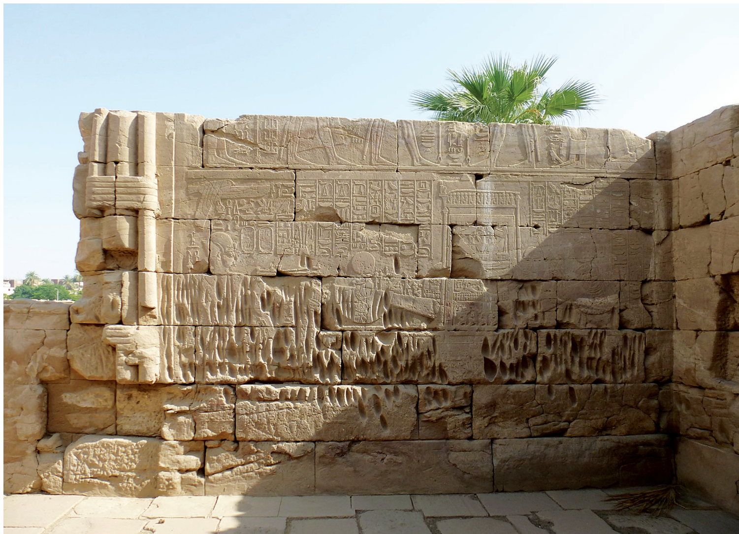
Fig 20. Liens à plusieurs hauteurs du pilier d'ante, chapelle d'Hakorîs à Karnak (© D. Valbelle)
