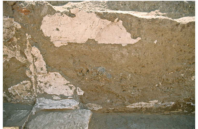
Fig. 49. Extrémité est du portique 100A, empreintes d'un revêtement en dalles de calcaire sur le mur est, en regard du pavage de sol
