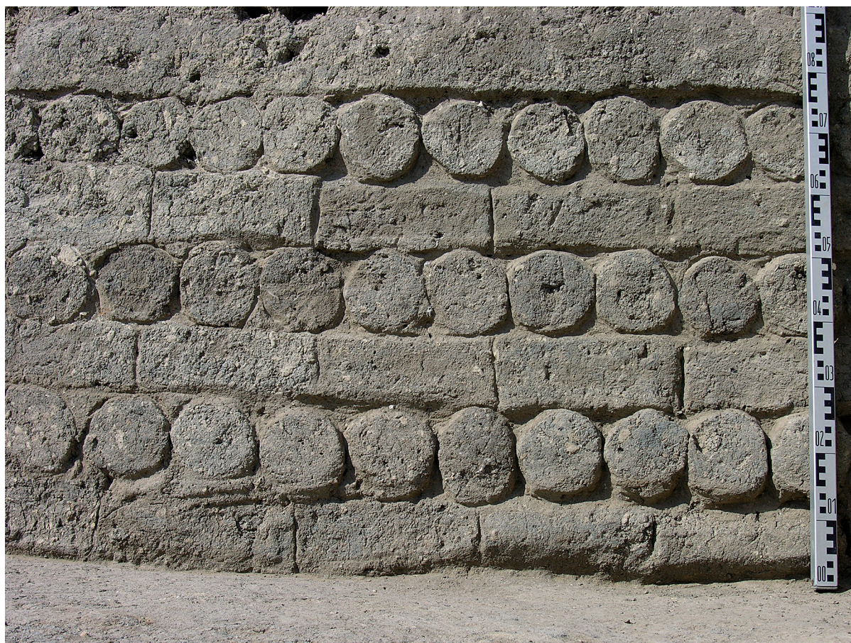
Fig. 30. Briques cylindriques de composition plus homogène et compacte, mises en œuvre dans les élévations (ici celles d'un édifice de la phase VA)
