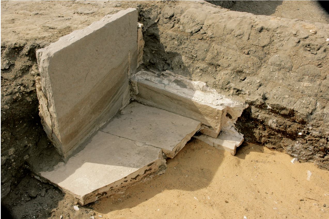
Fig. 79. Vue de détail de l'angle sud-est du bassin pendant son démontage : notons le lit de sable pur en fondation des dalles de pierre calcaire
