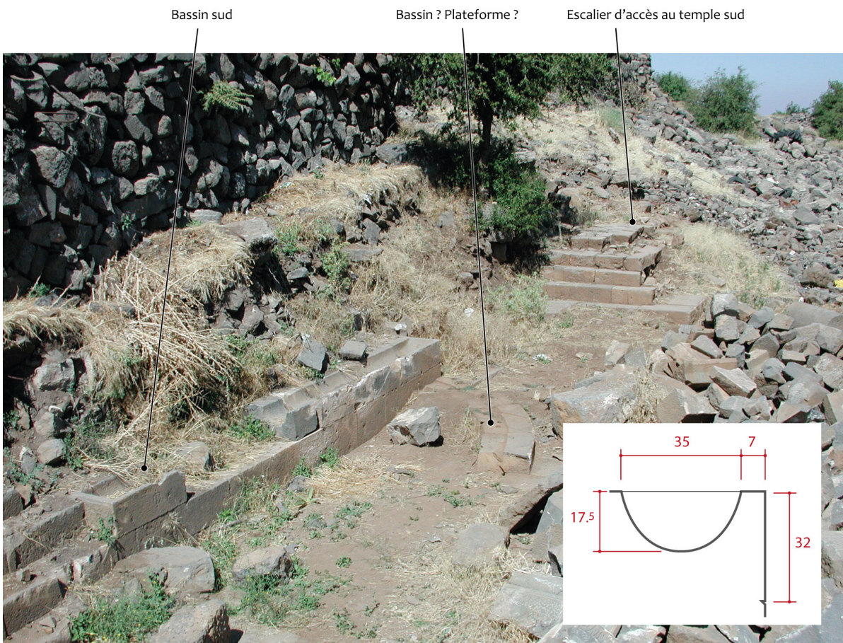
Fig. 22 : Première cour du sanctuaire de Sia (Syrie du Sud), vue et coupe sur le bassin (Th. Fournet, MAFP/lfpo).
