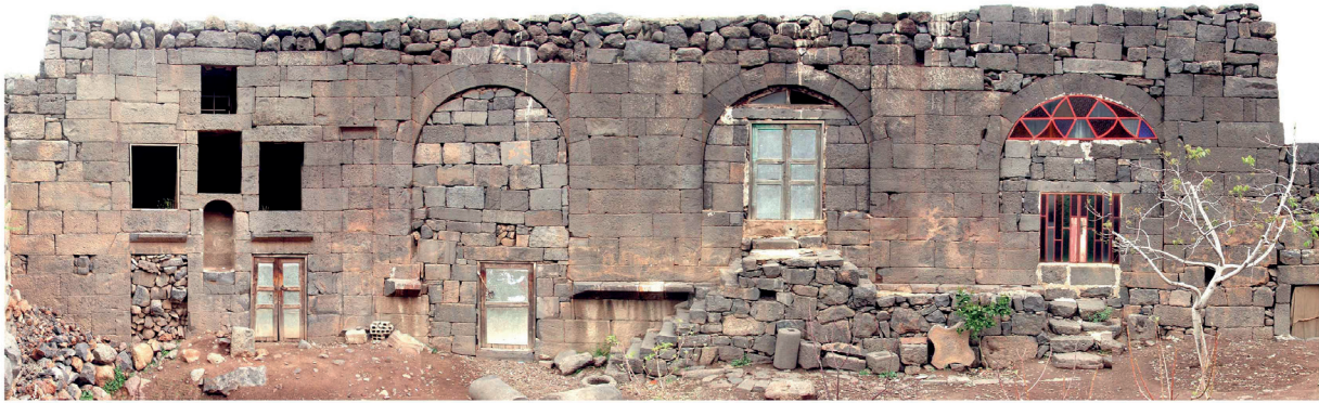
Fig. 4 : façade sud des bains romains de Sleim (Syrie du Sud, Th. Fournet)
