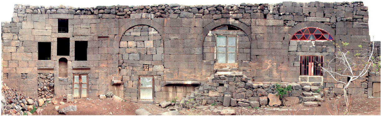
Fig. 4 : façade sud des bains romains de Sleim (Syrie du Sud, Th. Fournet)
