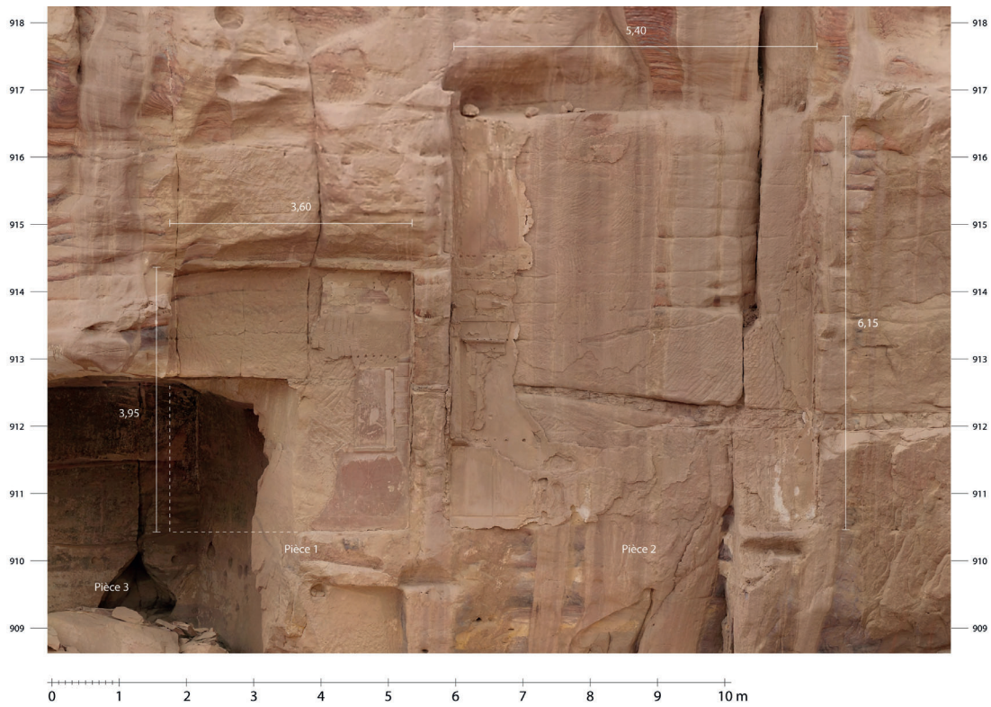
Figure 5. Orthophotographie des parois stuquées (élévation est), dimensions principales (T. Fournet MAFP/Ifpo 2020, sur une base photogrammétrique).
