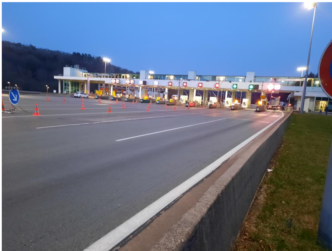
Illustration 2 : vue de la voie à la barrière de péage
