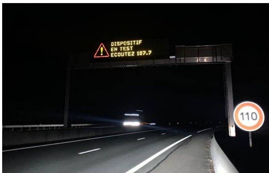
Illustration 1 : vue du PMV situé à 900 m de la barrière de péage (© APRR)
