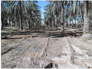
Photo 5 : Décapage de la croute de salinité
