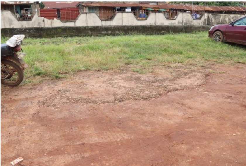
Fig.19 : situation du pavement sur le site
