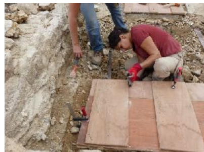
Prise en sandwich avec serre-joints ou sangles
