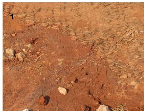
Fig. 32 : après un week-end de fortes pluies, le solin s'est dissous
