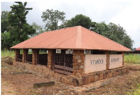
Fig. 40 : abri du pavement n°1 trouvé
