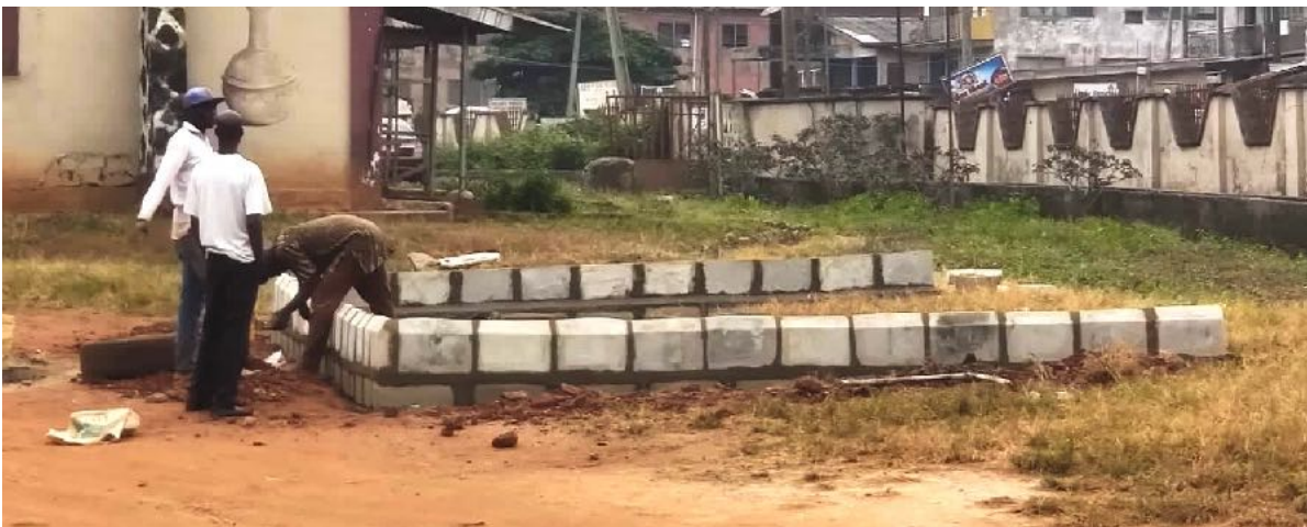
Fig. 43 : construction du mur de brique autour du pavement de la zone H
