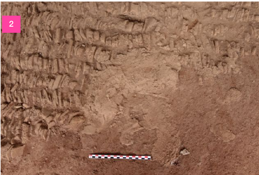
Fig. 15 : « réparation » moderne faite avec du ciment
