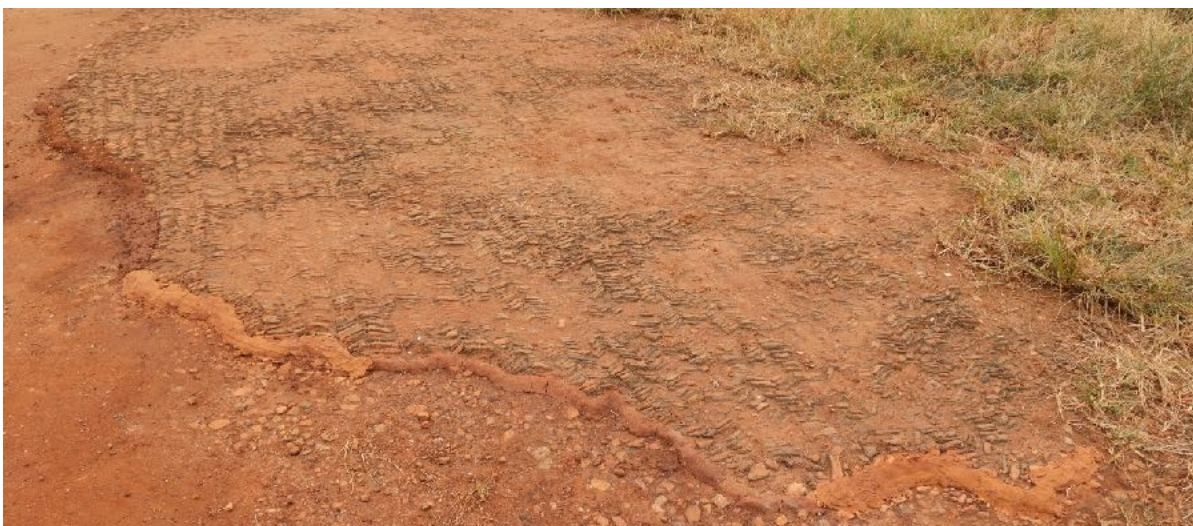
Fig. 38 : vue générale de tous les tests de solins
