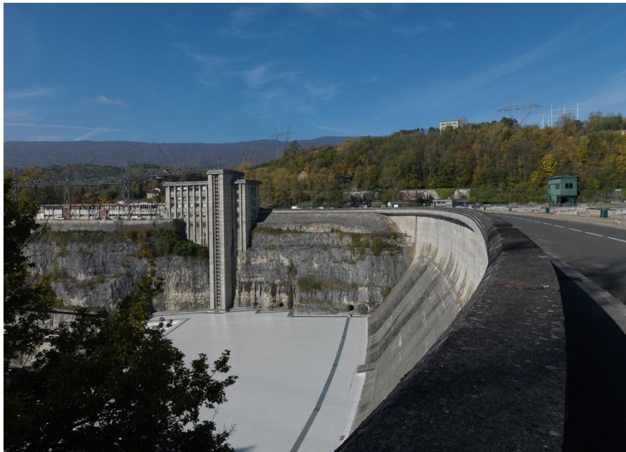
Figure 6 : Vue d'ensemble du barrage de Génissiat, Leroy Thierry, © Région Auvergne-Rhône-Alpes, Inventaire général du patrimoine culturel.
