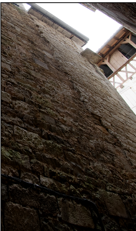
Fig. 18 : Photographie de la reprise entre l'appareil réglé de moellons et la portion la plus récente (Cl. Eric Chabanne).
