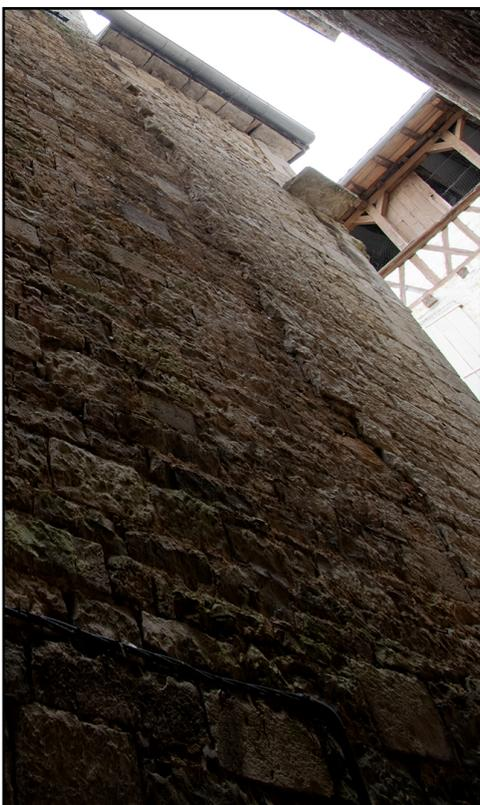
**Fig. 18 :** Photographie de la reprise entre l'appareil réglé de moellons et la portion la plus récente (Cl. Eric Chabanne).
