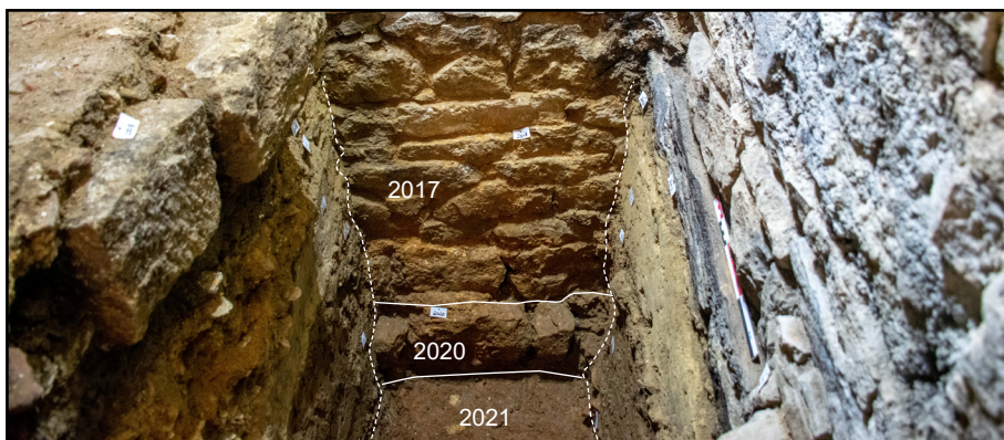
Fig. 49 : Vue des maçonneries du MUR 102 (Cl. Eric Chabanne).
