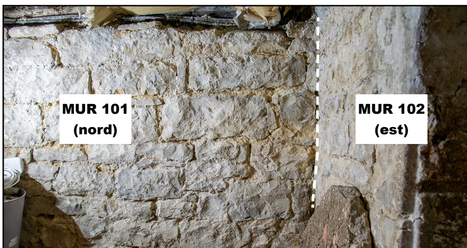
Fig. 13 : mur nord de la maison (MUR 101) non chaîné avec le mur est (MUR 102) (Cl. : E. Chabanne).
