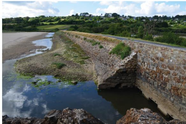
La digue-route Rozan
