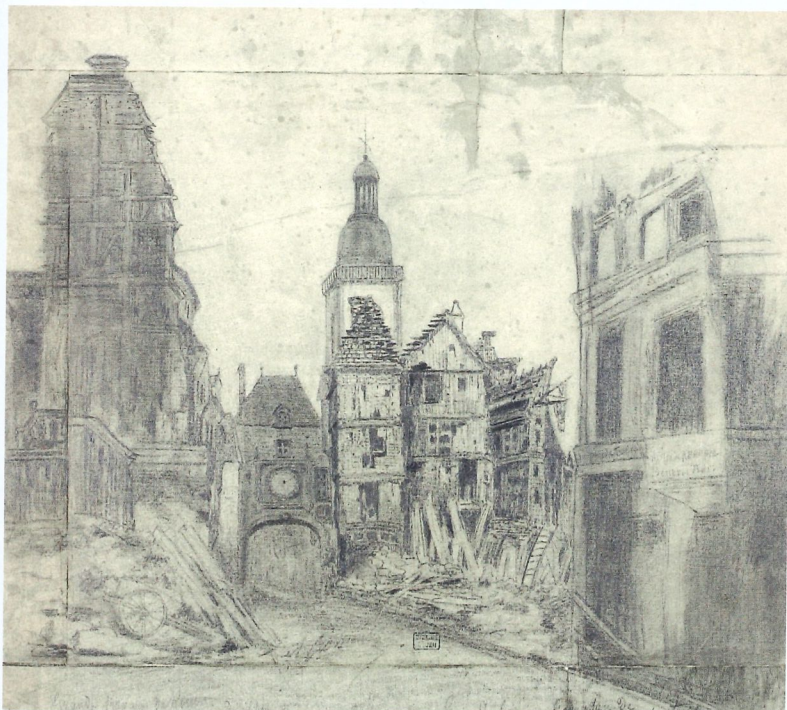
Fig. 11. Travaux de la rue de la Grosse-Horloge pour l'ouverture de la rue de l'Impératrice, Bibliothèque municipale de Rouen, Est. topo. g 4429.
