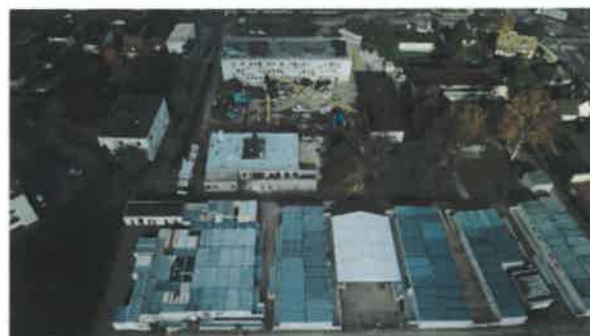
Vue d'ensemble du chantier et du collège provisoire (Merci à la section photo du Lycée Molière)
