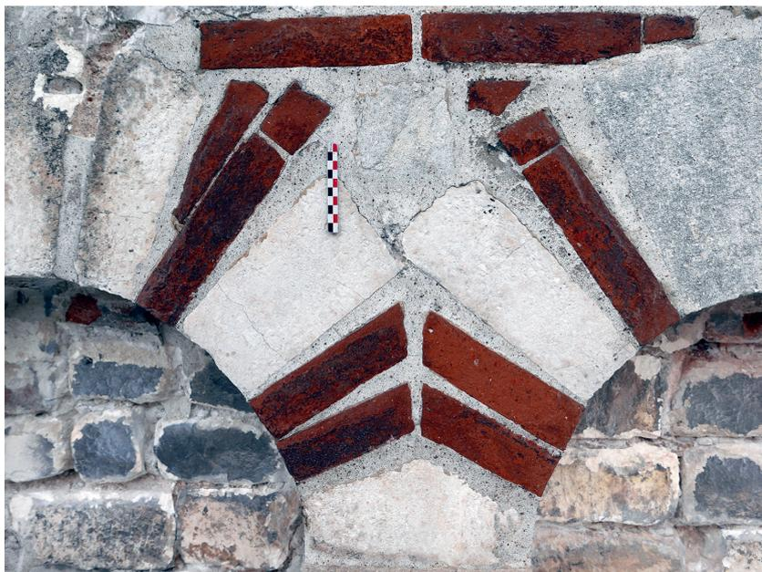
*ill. 10 : Détail d'un assemblage de briques mises en œuvre au XIX<sup>e</sup> siècle lors de la restauration du clocher.*
