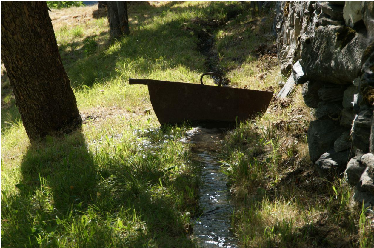
Figure 7 : "Tourne" métallique, Canal de la Vigne, Hauteville-Gondon, 19/7/12 (cliché A.-M. Bimet)
