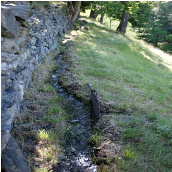
Figure 27 : Canal de la Vigne, mur de soutènement et tourne, Hauteville-Gondon 5/7/12 (cliché B. Meilleur)
