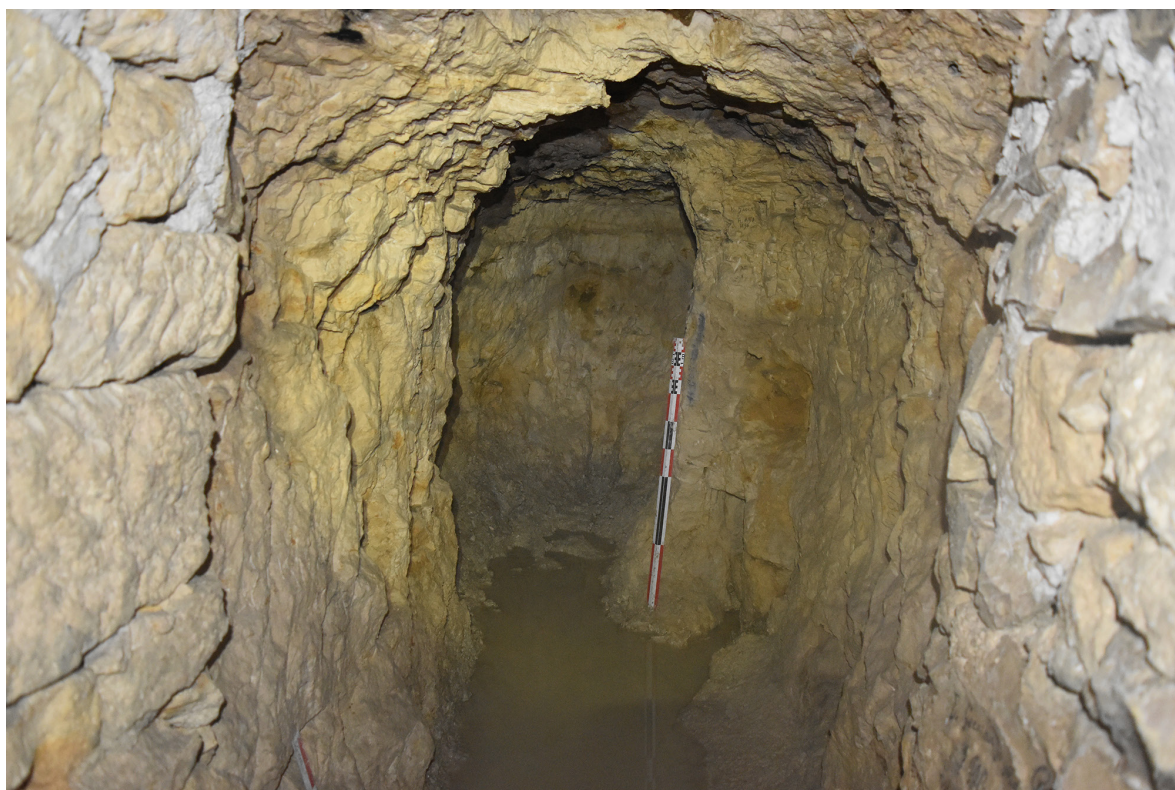
Figure 9 : Vue générale de la chambre de captage de la Petite Saussaie. © V. Bayard-Maret, CD94.
