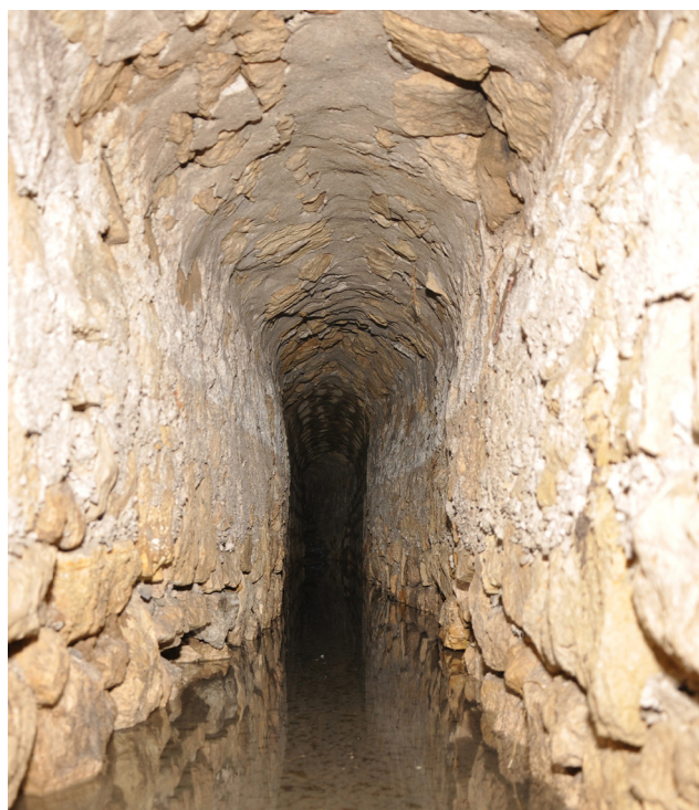
Figure 10 : Galeries des aqueducs du collège G. Monod et de la Petite Saussaie. © D. Barrau et V. Bayard-Maret, CD94.
