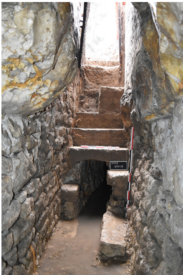
Figure 11 : Escalier d'accès à l'aqueduc de la Petite Saussaie. © V. Bayard-Maret, CD94.
