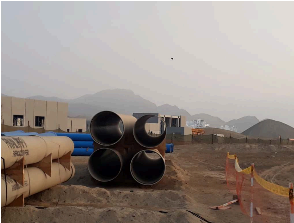
Figure 5. Usine Provisur en construction, avec en arrière-plan les édifices de Santa Maria del Mar
