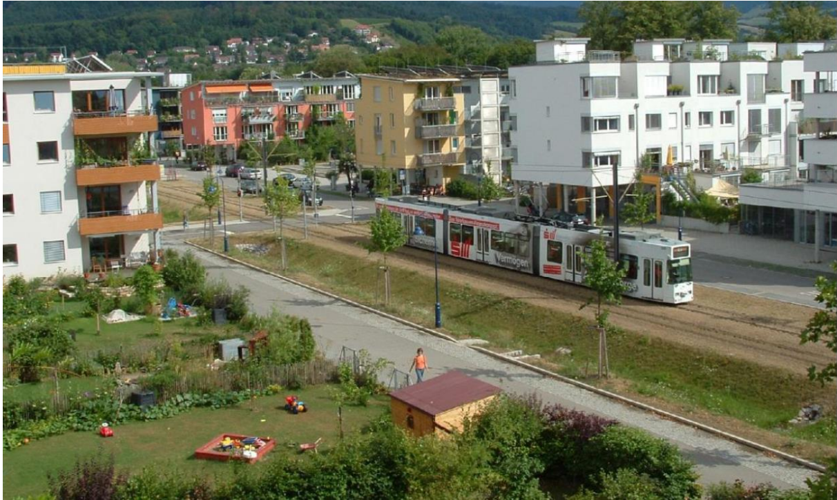
Figure 37 : Vaubanallee, avec le tram depuis 2006, entouré de l'allée centrale en zone 30, en forme de U pour limiter le trafic routier. Crédits : Steve Melia
