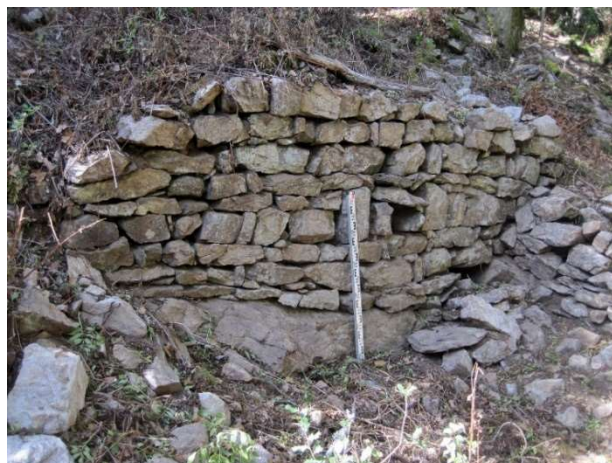
Figure 111: La plupart des remparts (murs défensifs et autres) sont le plus souvent stabilisés par des ancrages sur le substratum rocheux
