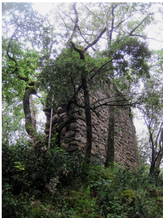
Figure 112: Important mur bouclier situé au nord du site. Effondré vers l'est et l'ouest. Il surplombe un fossé sec défensif
