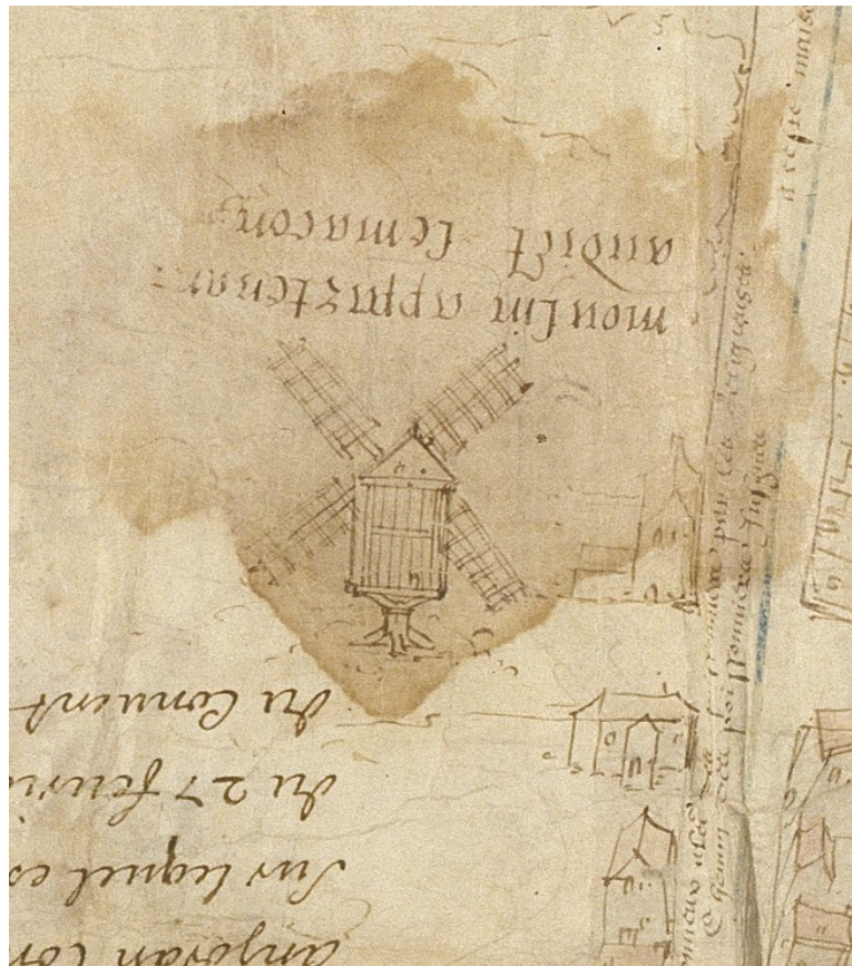
Figure 9. Un moulin sur pivot en 1559. La majorité des moulins à vent édifiés à Paris au XVI e siècle, prenaient la forme du moulin sur pivot, consistant en une cage de bois reposant sur un pivot charpenté ou maçonné. L'escalier extérieur permettant d'accéder à la cage servait souvent à orienter le moulin. Certains moulins, comme celui-ci, avaient été installés sur des reliefs artificiels formés par l'accumulation de déchets (appelés gravois) afin de profiter d'une meilleure exposition au vent. (« Plan figuré et description du lieu appelé la Ville neufve sur Gravois », vue cavalière, Arch. nat. CP S 6626).
