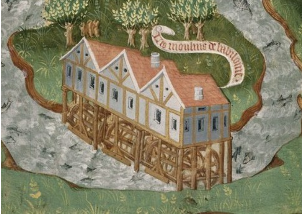
Figure 6. Les moulins de Babylone (1444-1445). L'enlumineur du Roman d'Alexandre s'est probablement inspiré des moulins du Pont aux Meuniers. Au XV e siècle, il s'agissait de moulins pendus assis sur des pilotis de bois. Le moulin est alors un lieu de vie pour le meunier qui peut ainsi le surveiller comme le montre la présence de cheminées. ( Roman d'Alexandre en prose , British Library, Royal MS 15 E VI, fol. 4, © British Library).
