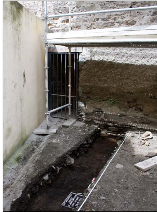
Fig. 10: Le sondage SD1, dans la partie sud du chevet, pour l'installation du réseau électrique.
