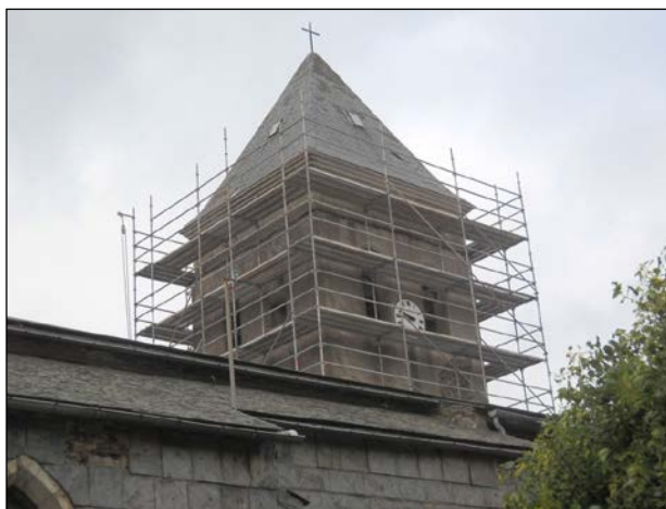
Fig. 6 : Restauration du clocher de l'église Saint-Jean-Baptiste de Villardonnell (Aude).
