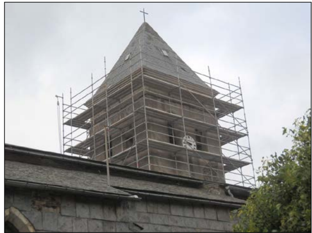
Fig. 6 : Restauration du clocher de l'église Saint-Jean-Baptiste de Villardonnell (Aude).
