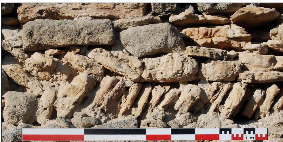
**Fig. 18 :** Détails des moellons gréseux disposés *opus spicatum*.
