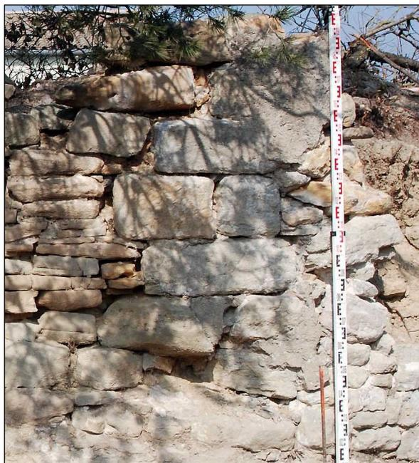
*Fig. 25 : Chaînage d'angle (UC 1120) du mur UM 1101.*
