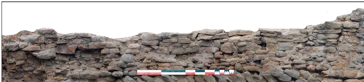
Fig. 31 : Détail de l'UC 4107, surélévation reposant sur l'UC 4105 (opus spicatum).
