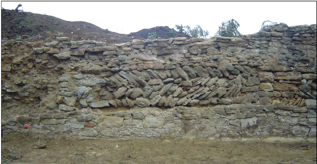
Fig. 9 : Vue partielle du mur de l'ancien cimetière de Villesèquelande, avant sa consolidation par l'Amicale laïque de Carcassonne.
