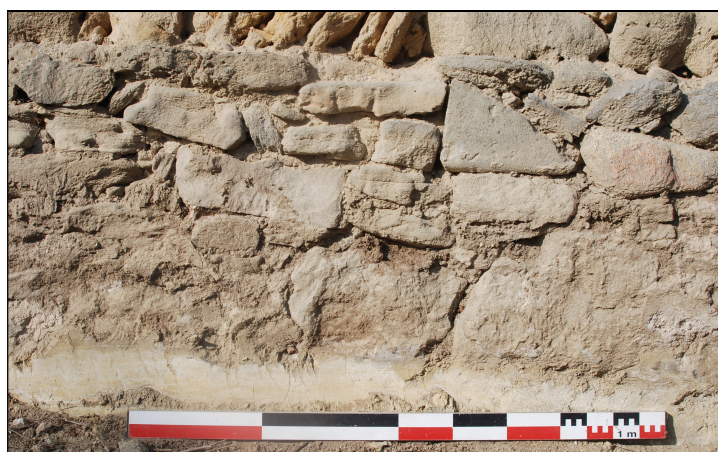
Fig. 27 : Détail de l'UC 4102, reprise en sous-œuvre du mur UM 4101.
