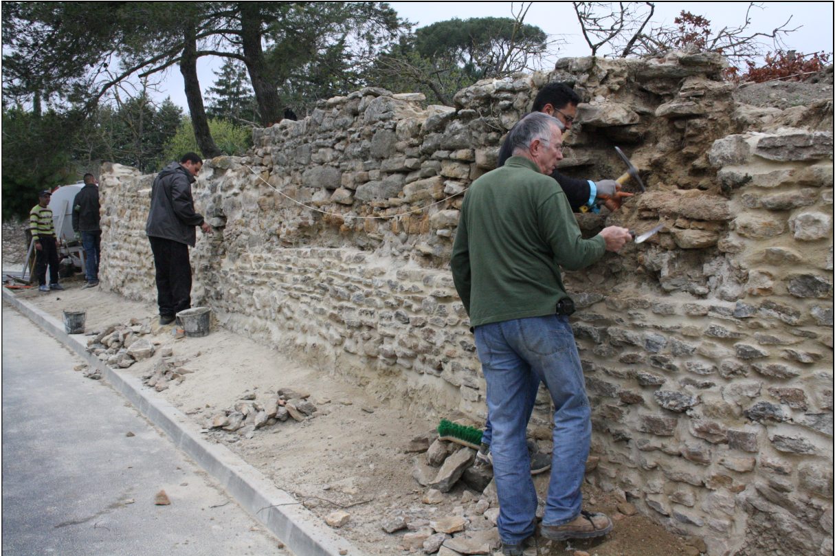
Fig. 33 : Restauration/consolidation du mur sud du « Cimetière Vieux » de Villesèquelande par le chantier d'apprentissage de l'Amicale Laïque de Carcassonne.
