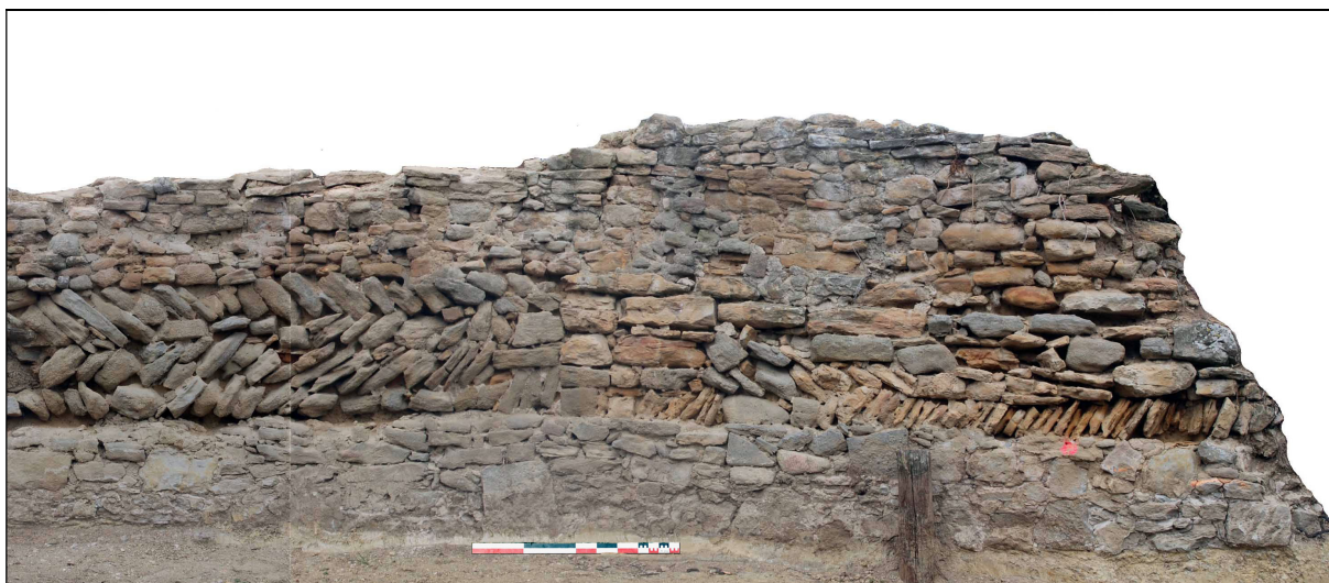
Fig. 26 : Vue d'ensemble du mur UM 4101.
