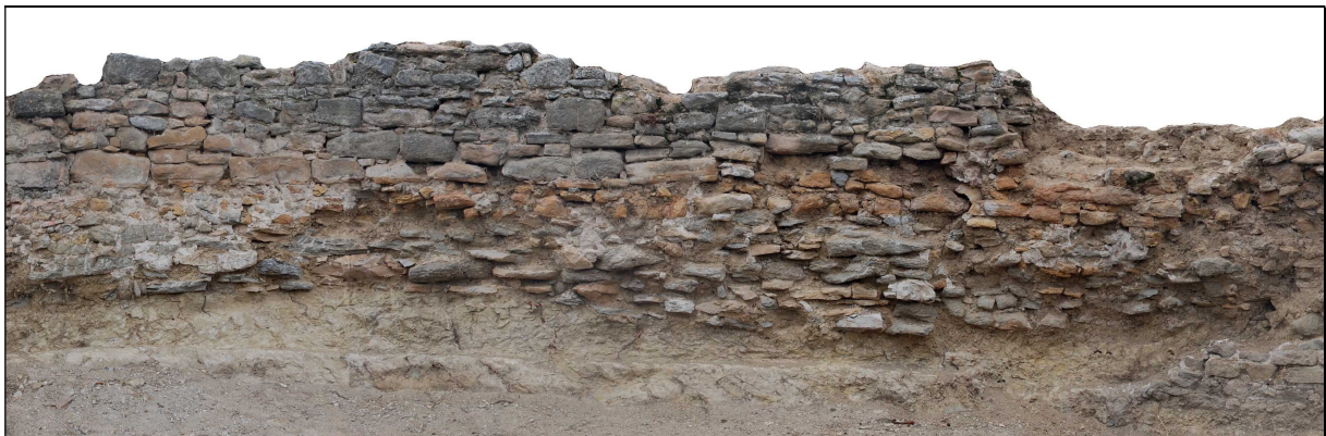
Fig. 32 : Partie centrale du mur UM 4100, reposant sur le substrat gréseux (US 1002).
