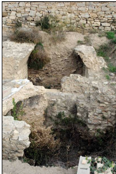
Pièces voûtées faisant partie des thermes. Au fond, le mur de clôture du cimetière (certains joints sont lessivés ; cliché : J.-F. Modat).
