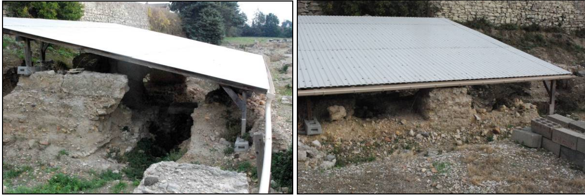
Protection des structures : exemple de toiture en tôle avec gouttière PVC évacuant les eaux pluviales, îlot III (cliché : J.-F. MODAT).
