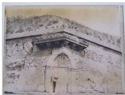
Fig. 4 : Photo ancienne (XIX e siècle) : Saillant du Bastion Saint-François avant son démantèlement (fonds photographique de la ville de Narbonne)
