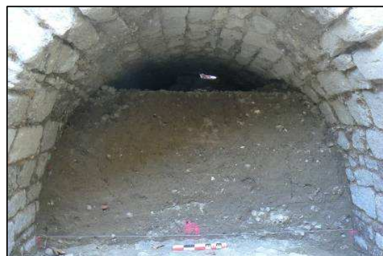
Fig. 12 : aspect intérieur de la voûte
