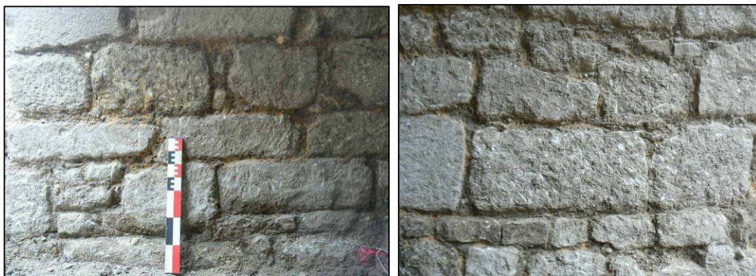
Fig. 13 : Parement intérieur nord et sud du tunnel
