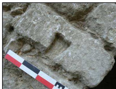
Fig. 10 : Queue d'aronde dans un bloc antique en remploi.
