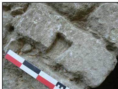
Fig. 10 : Queue d'aronde dans un bloc antique en remploi.
