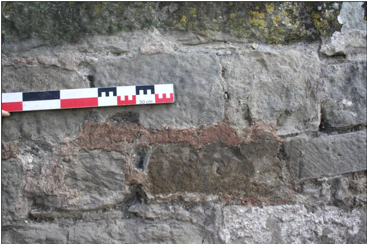
Fig. 15 : Traces d'enduit de citerne (US 3002) sur le mur d'enceinte (MR 3001).
