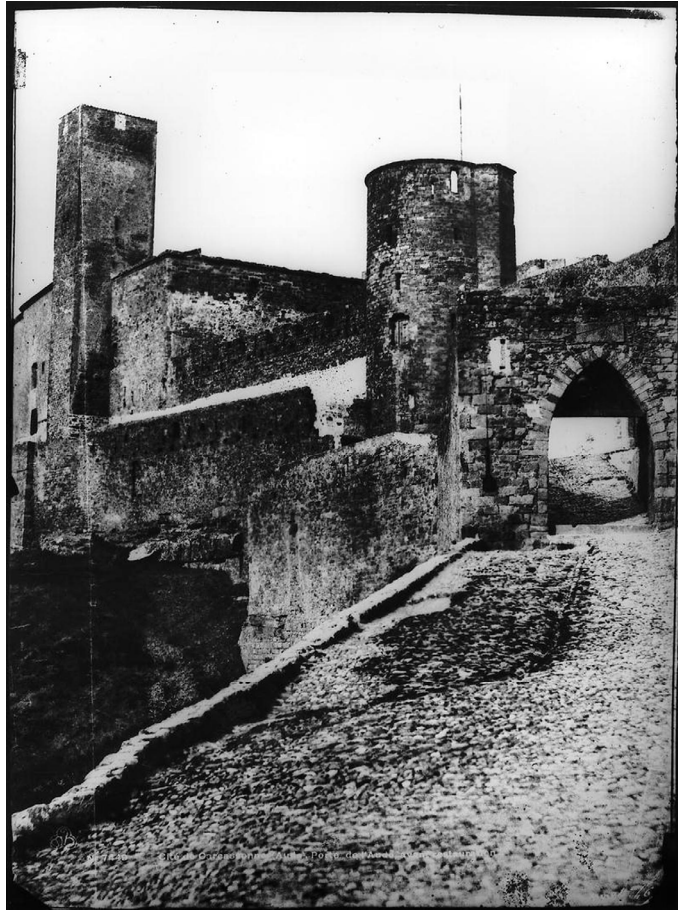
Fig. 60 : Photographie de la Porte d'Aude avant sa restauration (milieu XIX e s., fonds Viollet-le-Duc).
