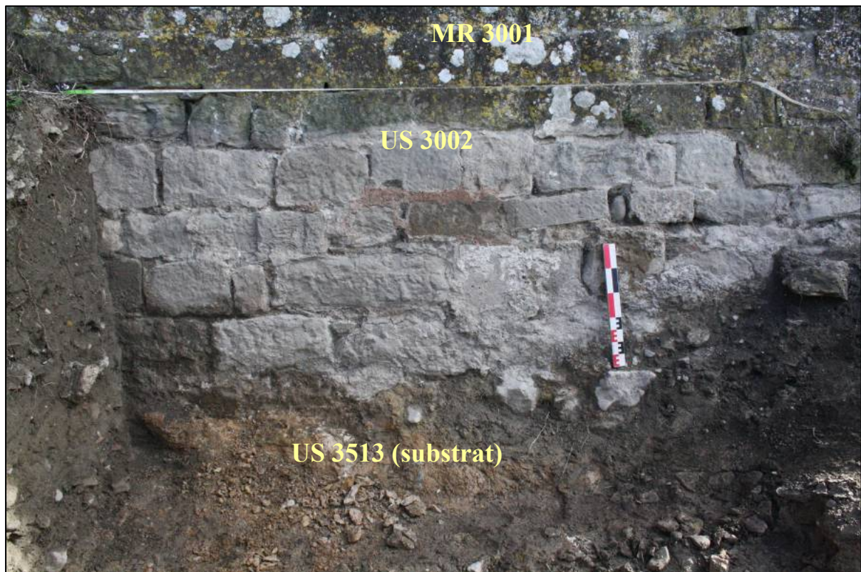
Fig. 14 : Base du mur de l'enceinte dans le sondage 3.
