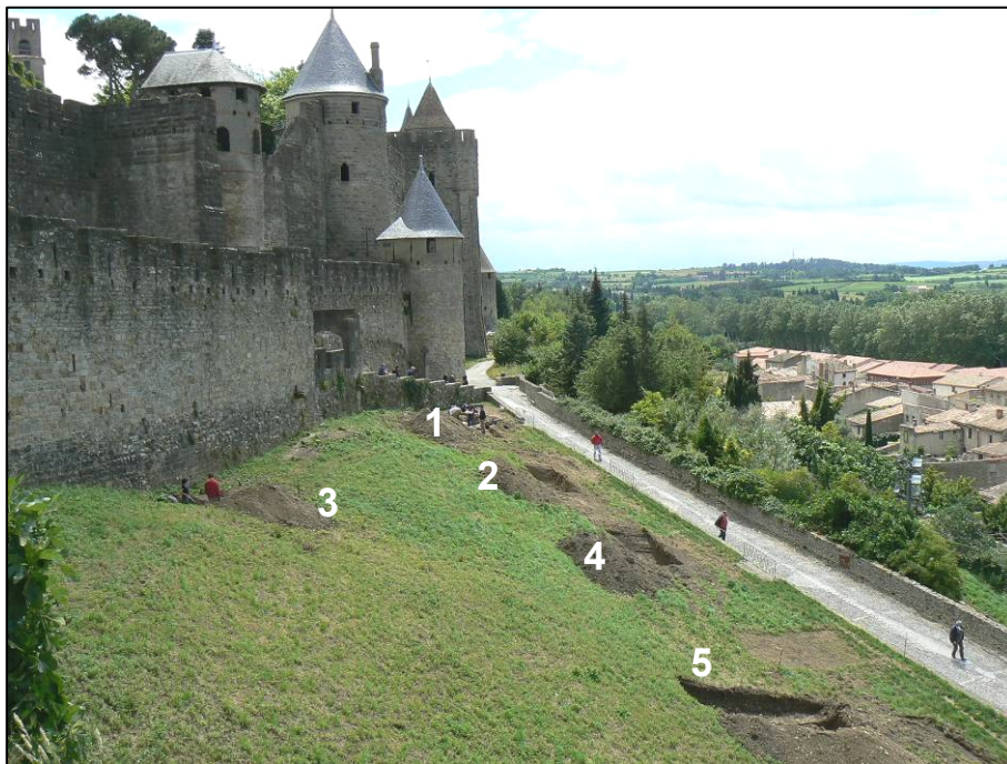
Fig. 5 : Implantation des sondages effectués en 2008.
