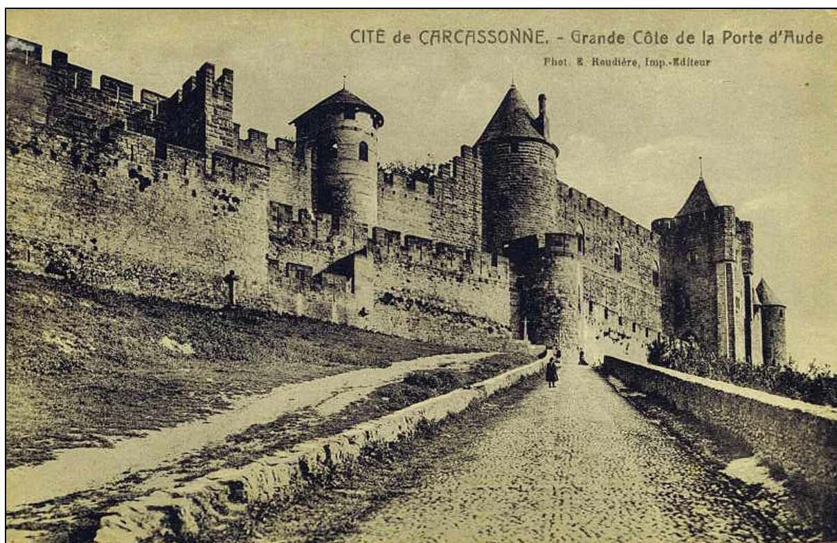
Fig. 65 : La rampe d'accès à la Porte d'Aude dans les années 1930 : le talus est en friche (carte postale ancienne).
