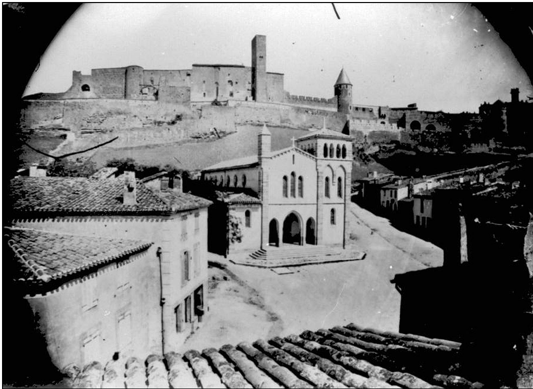
Fig. 61 : Photographie du front ouest après la construction de l'église Saint-Gimer et avant la restauration de la Cité (deuxième moitié XIX e s., fonds Viollet-le-Duc).
