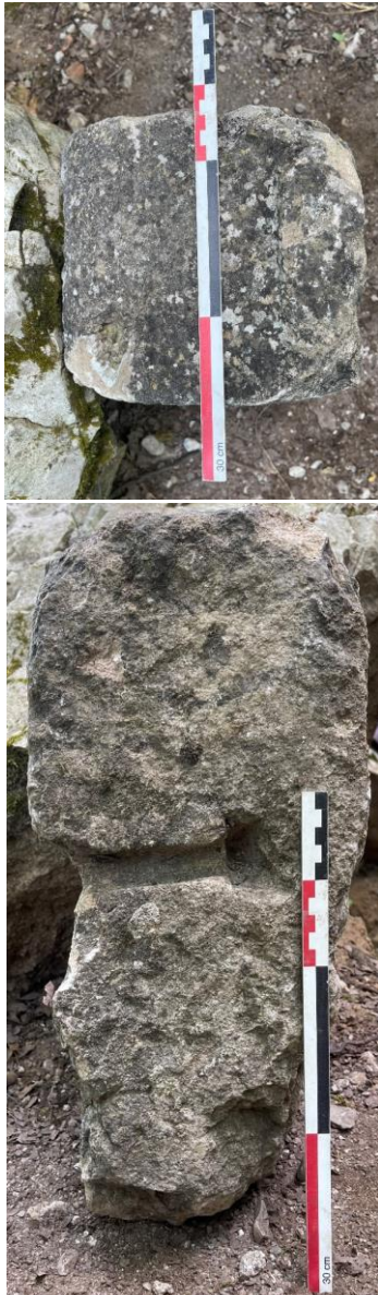
Fig. Pierre de taille avec encoche pour gond. Crédit F. Guillot
