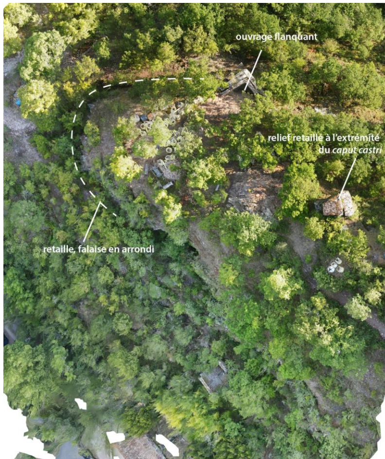
Fig. Contexte. Orthomosaïque de la photogrammétrie de l'extrémité nord-ouest du castrum. Crédit F. Guillot
