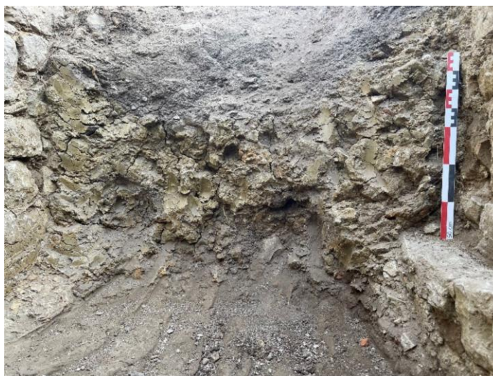
Fig. Berme du creusement profond dans la tranchée du forage. À gauche l'enceinte, M30 et à droite le M47. On distingue aisément la couche d'argile et le niveau perturbé au 20 e siècle au-dessus. Crédit Florence Guillot.
