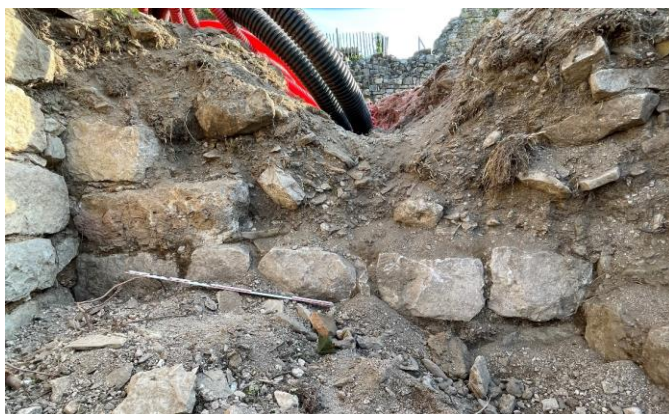
Fig. Vestige du parement sud du M27 dérasé apparaissant dans la tranchée du forage. À gauche le M30 et à droite le M47. Crédit Florence Guillot
