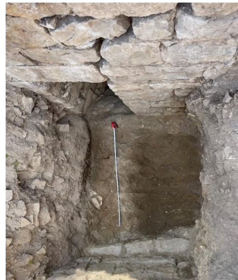
Fig. Vue du fond de la tranchée profonde; règle sortie à 1 m. Crédit Florence Guillot
