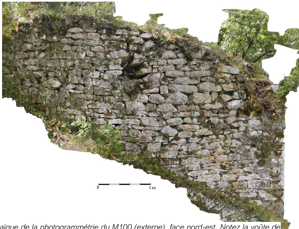
Fig. Orthomosaique de la photogrammétrie du M100 (externe), face nord-ouest. Notez la voûte de l'évacuation visible à droite de la base de l'angle. Crédit F. Guillot
