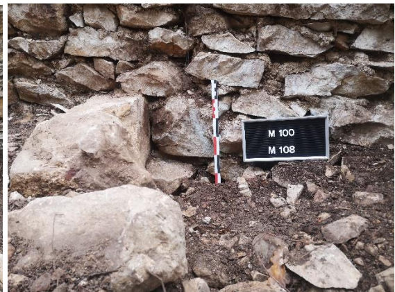
Fig. Terrasse M108 vue du dessus et chaînage d'un moellon dans M100. Crédit M. Bourdoux
