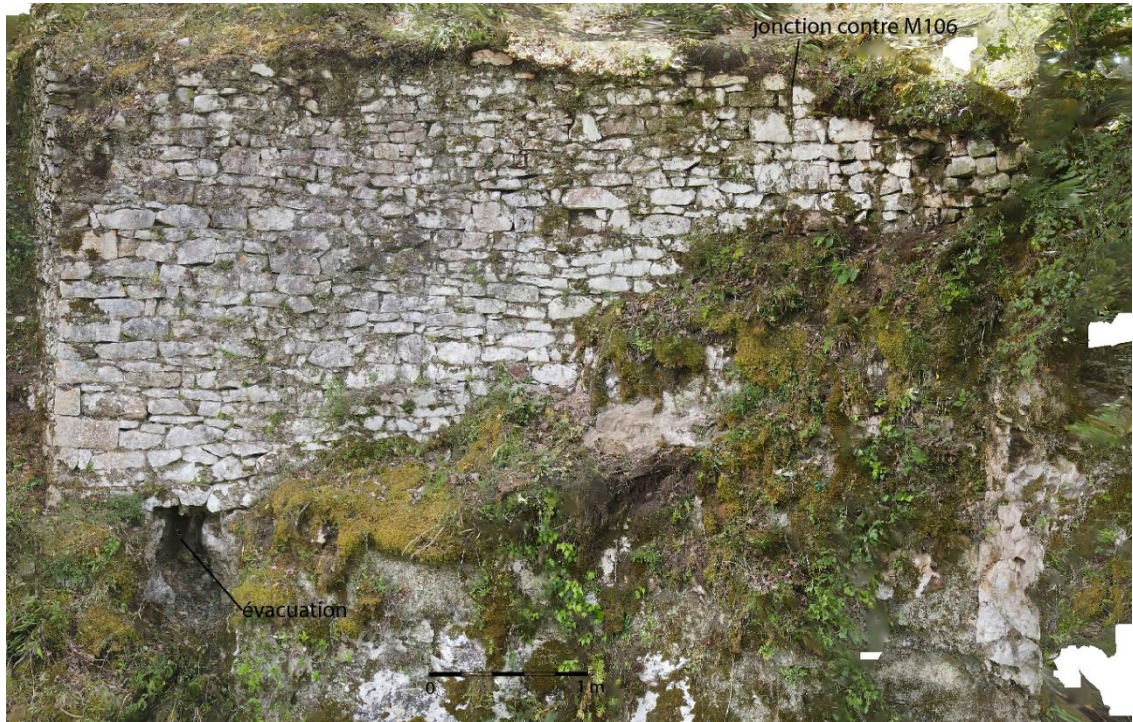
Fig. Orthomosaique de la photogrammétrie du M100 (externe), face nord-ouest. Notez la voûte de l'évacuation visible à droite de la base de l'angle. Crédit F. Guillot
