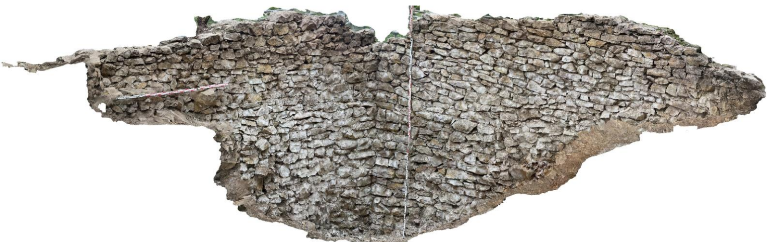
Fig. Orthomosaïque de la photogrammétrie en perspective dans l'axe de l'angle du M100 (interne). Le niveau plein débute à celui de la mire de gauche. Crédit F. Guillot
