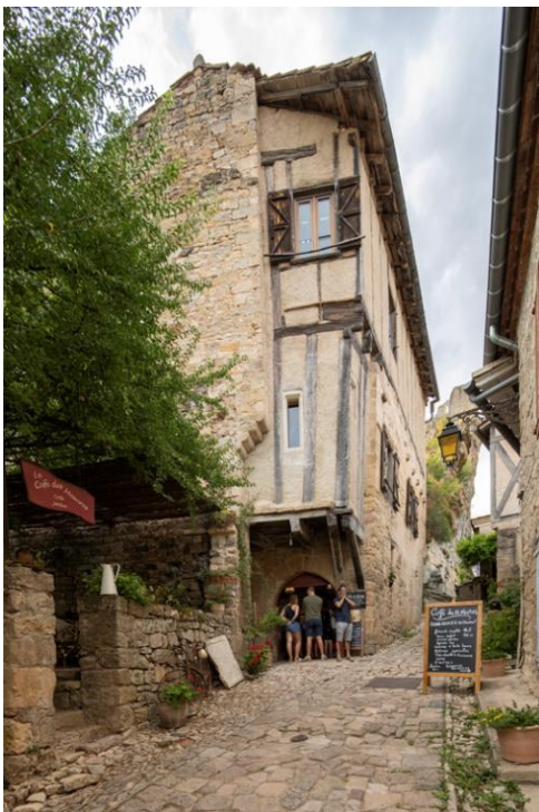
Fig. 5. Vue de la maison depuis le bas de la Grand-rue, avec la grande arcade au rez-de-chaussée (© A. Boyer, Inventaire général Région Occitanie, 2022)
