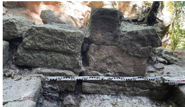
Fig. Piédroit nord de la porte d'origine (M92). Notez le manque à droite. Le piédroit a été réparé lorsqu'on a mis en place la pierre de seuil. Notez à gauche, le M95, quelques pierres encadrant les marches et mises en place avec elles. Crédit F. Guillot
