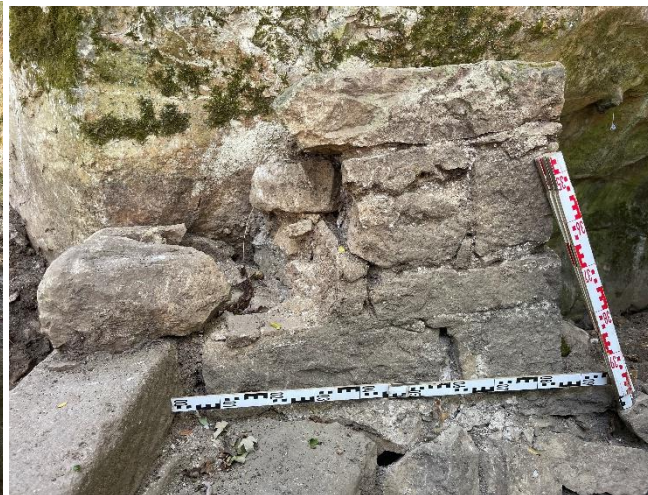
Fig. Piédroit sud de la porte d'origine (M92). Notez le manque à gauche. Le piédroit a été réparé lorsqu'on a mis en place la pierre de seuil. Crédit F. Guillot
