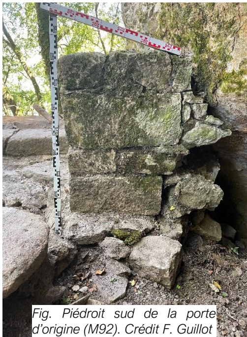
Fig. Piédroit sud de la porte d'origine (M92). Notez le manque à gauche. Le piédroit a été réparé lorsqu'on a mis en place la pierre de seuil. Crédit F. Guillot
