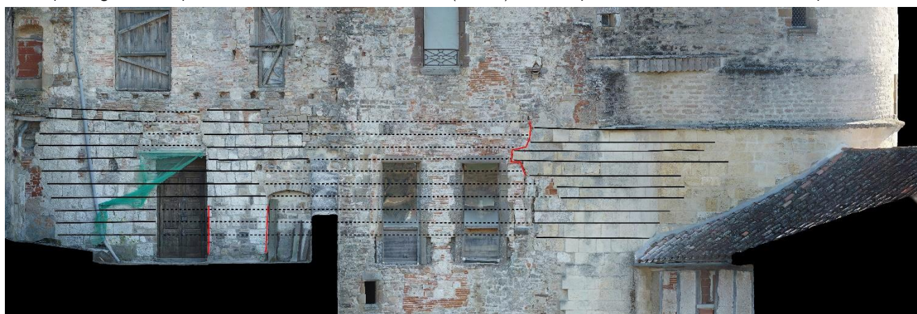
Fig. Concordance ou discordances des assises des unités de bâti de la courtine d'origine avec la tour nord. Extrait de l'orthophotographie de Pascal-Robert-Cols
