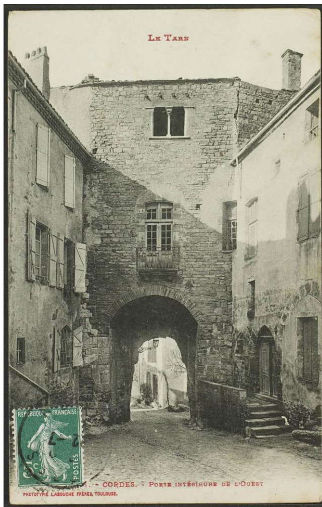
Fig. Interne de la porte des Ormeaux et façade de la maison Fabre. Collection SAVC, et AD81, Fi 00069-0171
