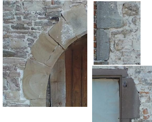
Fig. Exemple de grès dans les encadrements des ouvertures, parement externe M1. Extrait de l'orthophotographie de Pascal Robert-Cols
