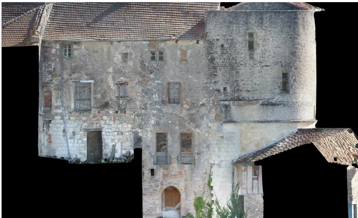
96. Orthophoto : Façade Nord avant piquage
