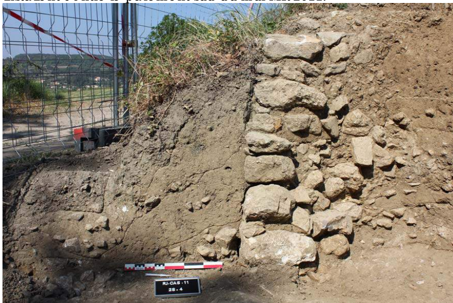
Fig. 163- Vue de l'est de la section 2S4 du mur MR 2011. © D. Lopez, CCNBT
