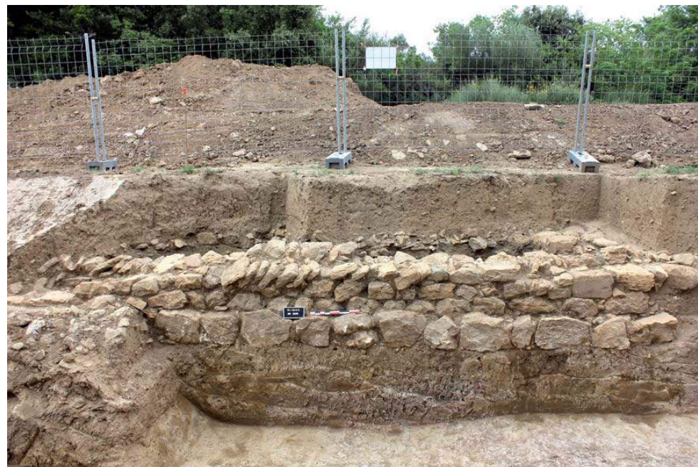
Vue du sud sur le parement (fondation et élévation) sud du mur MR 2008.
