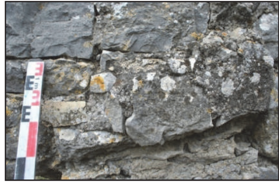
Fig. 93 : MR 6e, vestige d'ancrage d'une porte aujourd'hui détruite (photo : F. Loppe, 2012).
