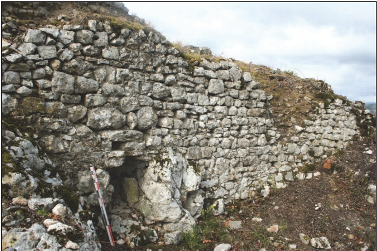
Fig. 73 : Le mur MR 1 bâti au devant du mur MR 3 et situé à l'aplomb du fossé entaillé (photo : F. Loppe, 2012).
