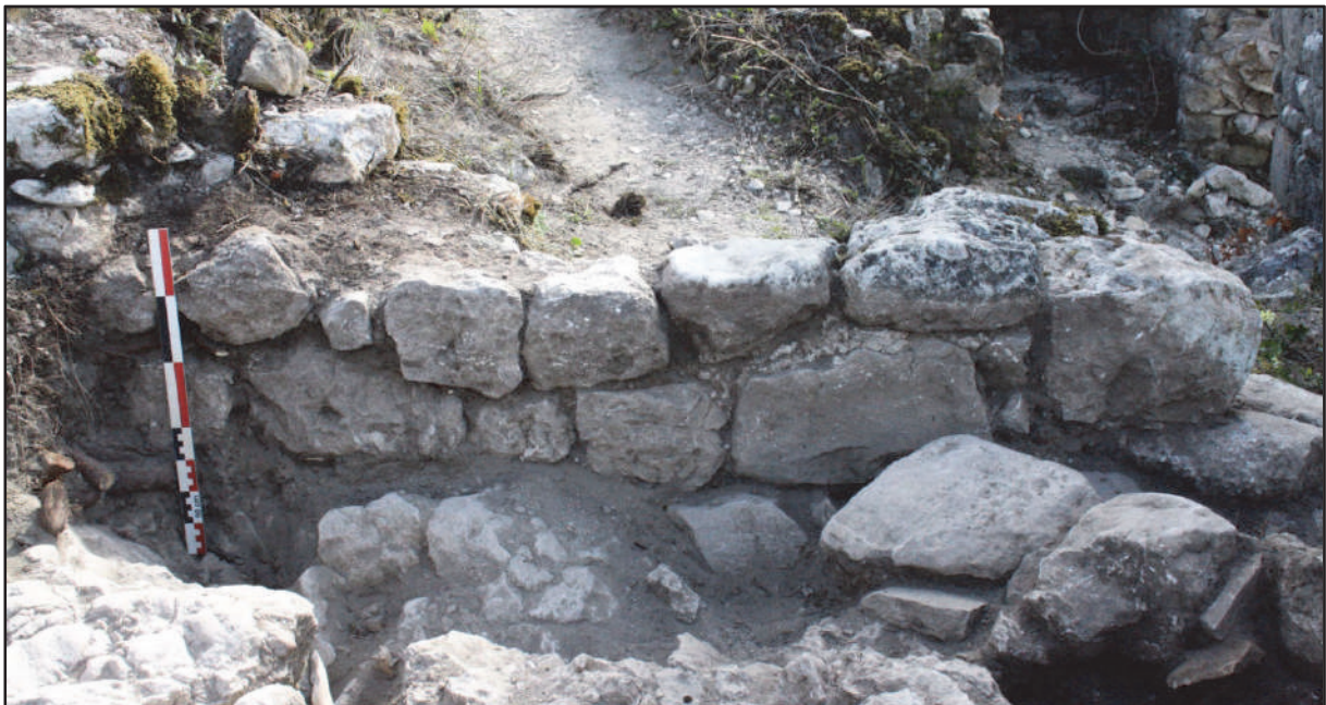
Fig. 38 : Le muret MR 15 lié au mortier de chaux s'appuyant sur le substrat rocheux (photo : J.-F. Modat, 2012).
