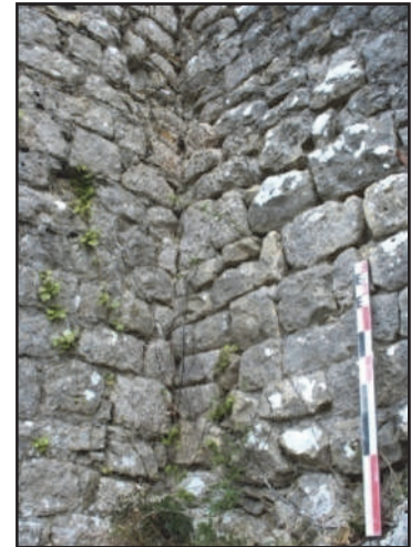
Fig. 98 : La tour TO 1 s'appuyant sans liaison contre le mur MR 6f (en bas) (photo : F. Loppe, 2012).
