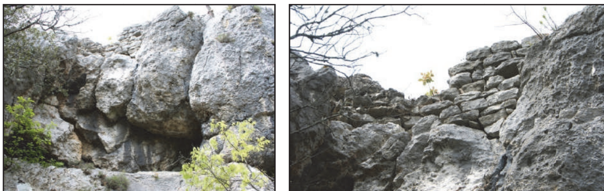
Fig. 110 : Le mur MR 18 vu de l'ouest, à surplombant les cavités naturelles (photos : F. Loppe, 2012).
