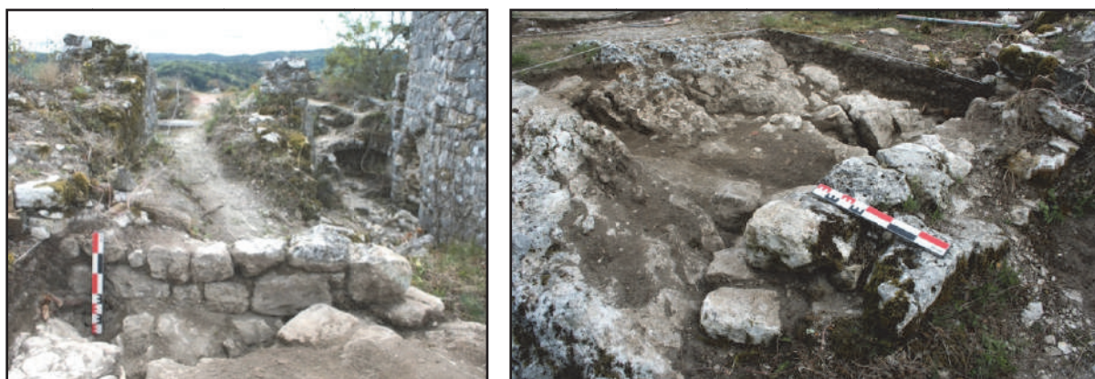
Fig. 109 : Le muret MR 15 lié au mortier de chaux maigre s'appuyant contre MR 18 (photos : F. Loppe, 2012).
