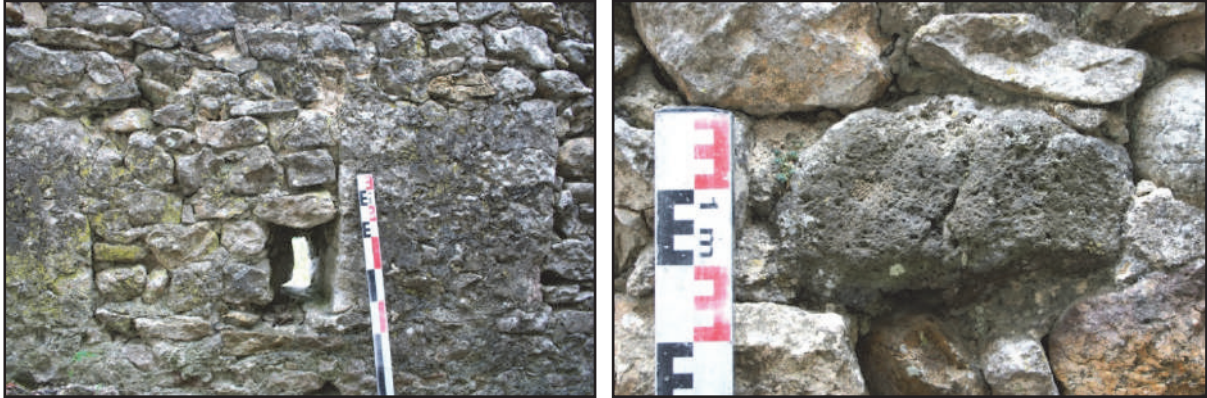
Fig. 104 : Le mur MR 7c composé de blocs divers en calcaire, grès et basalte (photos : F. Loppe, 2012).
