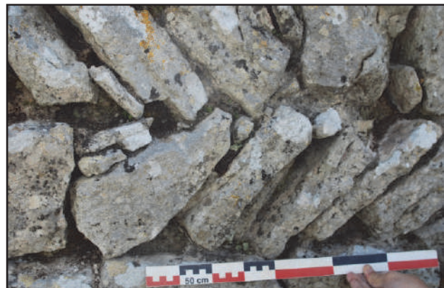
Fig. 95 : Assise en opus spicatum visible au niveau de l'arase du mur MR 6f (photos : F. Loppe, 2012).
