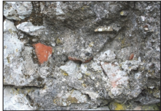
Fig. 82 : Maçonnerie MR 4d incluant des fragments de tuile (photo : F. Loppe, 2012).
