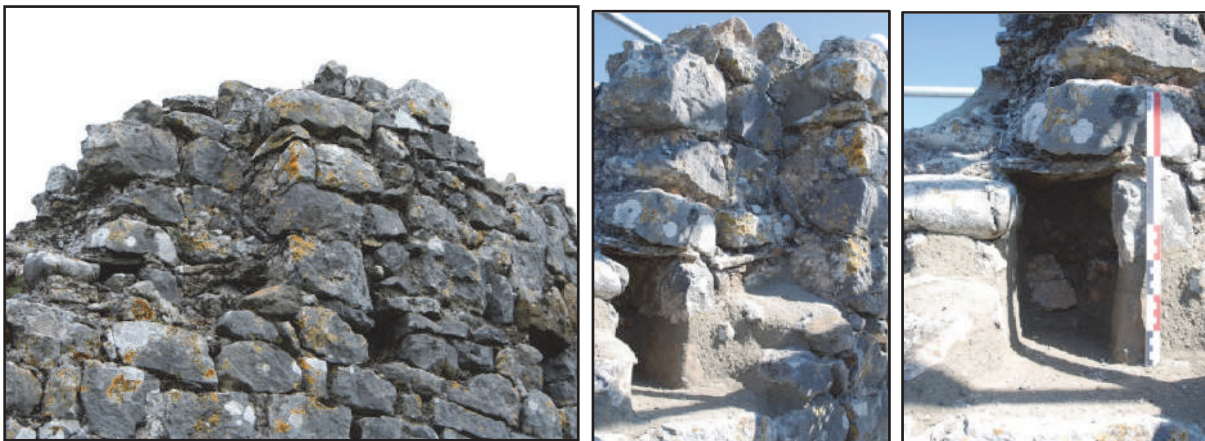
Fig. 87 : MR 6a, vestiges d'un chemin de ronde présentant un système de circulation charpenté en bascule (photos : F. Loppe et J.-F. Modat, 2012).
