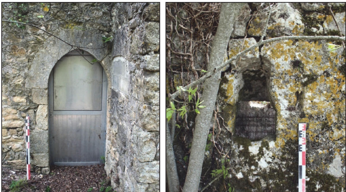
Fig. 10 : Quelques éléments architecturaux visibles sur les maisons du castrum : porte en arc brisé (à droite) et baie en partie aménagée dans le substrat rocheux (à gauche).
