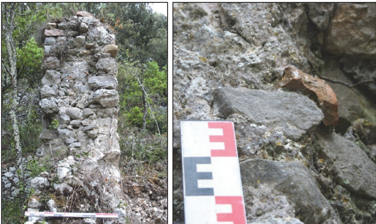
Fig. 115 : Blocage du mur MR 10a contenant des déchets de taille calcaires et une tuile (photos : F. Loppe, 2012).
