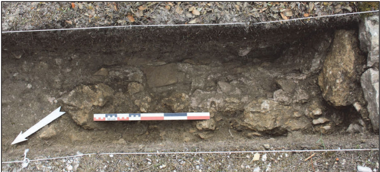
Fig. 19 : Semelle de mortier de chaux (US 1204) recouvrant un mortier de tuileau rose (US 1205), plaquée contre l'assise du mur MR 5e. Photo : J.-F. Modat, 2012.
