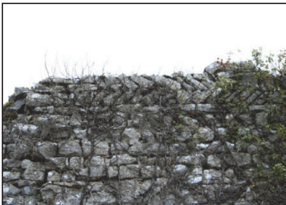
Fig. 95 : Assise en opus spicatum visible au niveau de l'arase du mur MR 6f (photos : F. Loppe, 2012).
