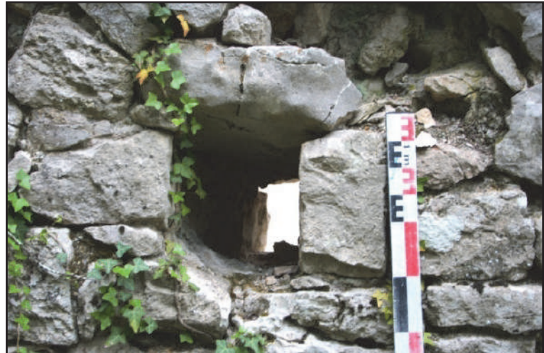
Fig. 114 : Trou de boulin à fourreau traversant visible sur le mur MR 10 (photo : F. Loppe, 2012).
