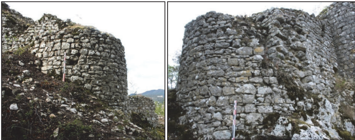
Fig. 77 : La tour TO 2, construction semi-circulaire appuyée contre le mur MR 1 et dont les mises en œuvres sont à rapproches (photos : F. Loppe, 2012).
