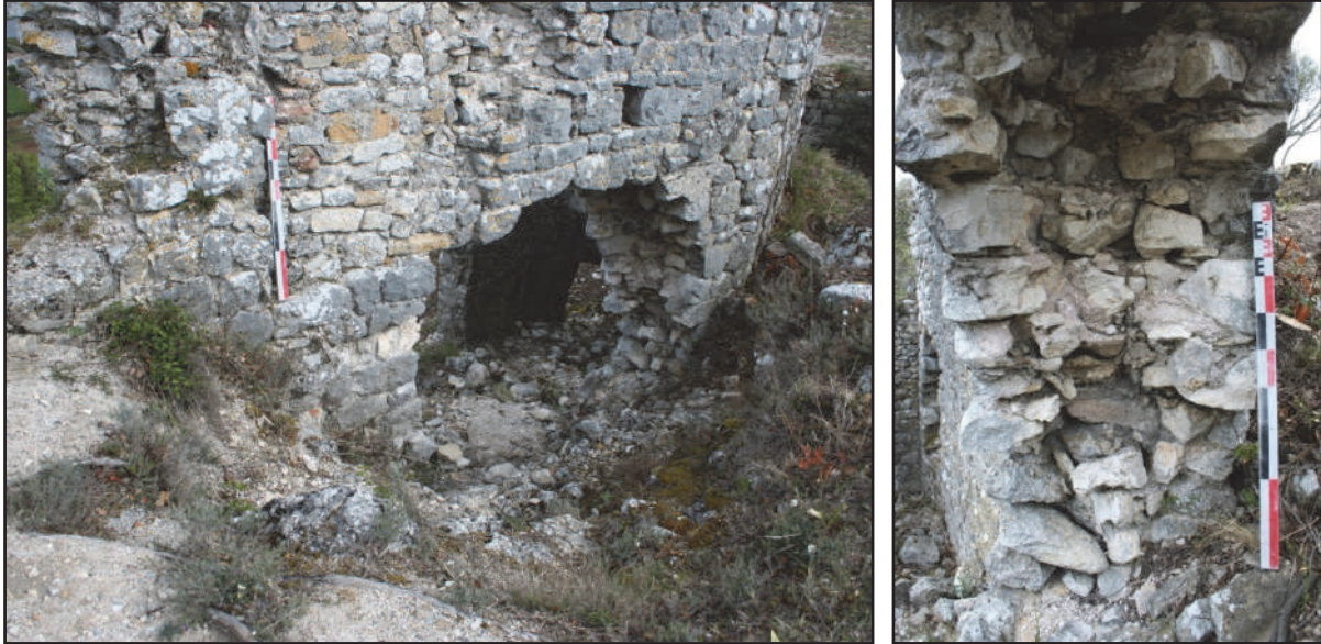
Fig. 86 : Le mur MR 6 vu de l'ouest (photo : F. Loppe, 2012).
