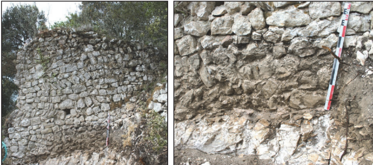
Fig. 112 : Parement est du mur MR 10 dont les assises reposant sur le substrat rocheux suivent la pente (photos : F. Loppe, 2012).
