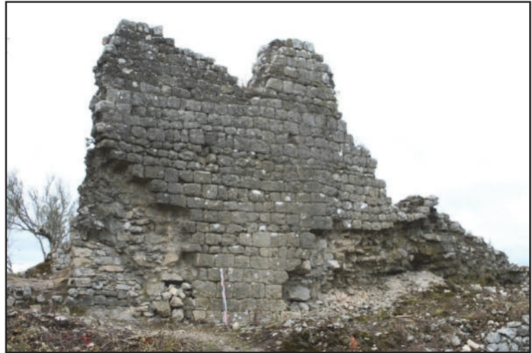
Fig. 63 : Parement externe du mur MR 3, vue du nord-est (photo : F. Loppe, 2012).
