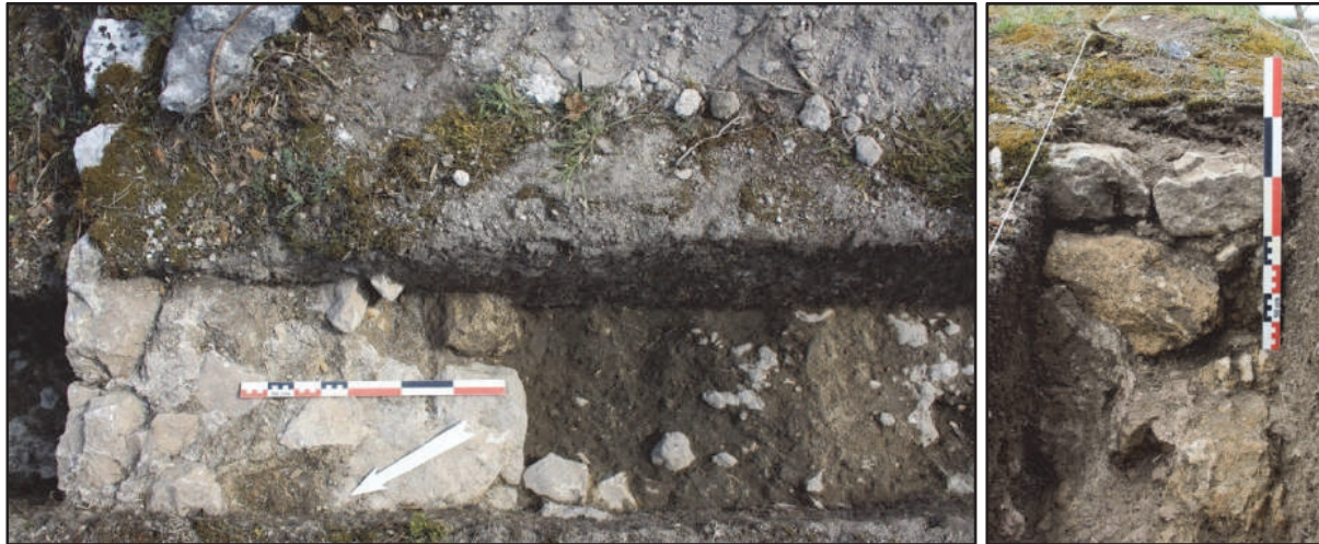
Fig. 20 : Le mur MR 5e au sud de la tranchée TR2. À gauche vue en plan : on distingue au sud le comblement de la tranchée de fondation (US 1209). À droite, les deux assises conservées reposant sur le substrat rocheux. Photos : J.-F. Modat, 2012.
