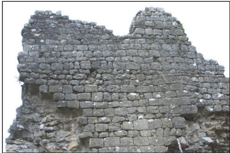
Fig. 67 : Le mur MR 3b, reprise de maçonnerie de MR 3a, visible jusqu'au niveau de l'arase (photo : F. Loppe, 2012).
