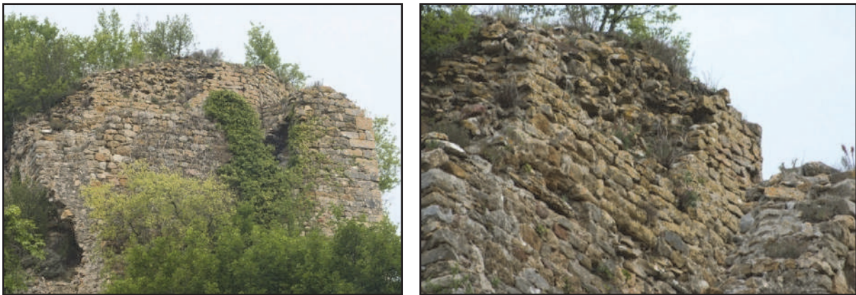
Fig. 118 : Château de Salavas, situé à quelques kilomètres du Vieux Vallon, présentant des maçonneries semblables au château étudié (photos : F. Loppe, 2012).
