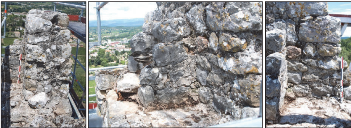
Fig. 72 : Aménagement postérieur au chemin de ronde, s'appuyant sur le parapet primitif (photos : F. Loppe, 2012).
