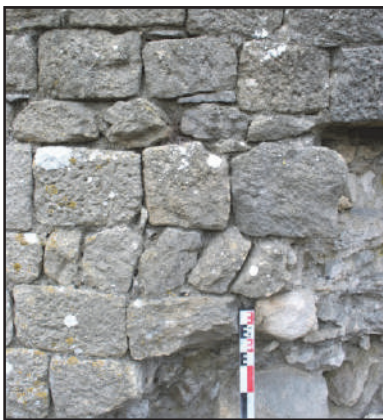
Fig. 68 : Moellons disposés de chant au niveau de l'arase conservée du mur MR 3a (photo : F. Loppe, 2012).
