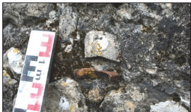
Fig. 100 : Présence de déchets de taille pour le calage des moellons et de fragments de tuile dans les jointements (photo : F. Loppe, 2012).
