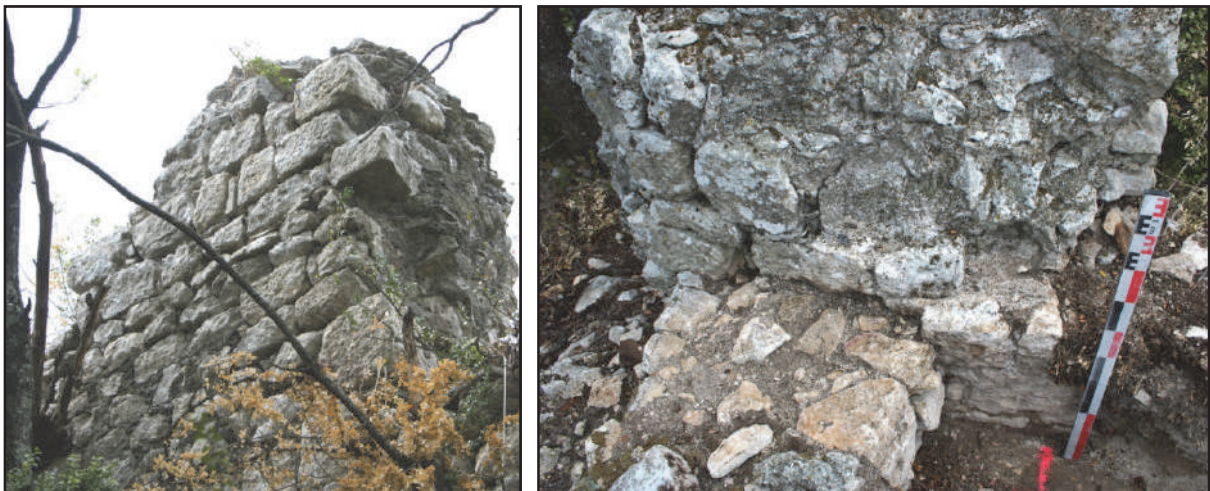
Fig. 106 : La maçonnerie MR 5b vu de l'est (à gauche) et de l'ouest (à droite) où s'appuie le muret MR 3e (photos : F. Loppe, 2012).
