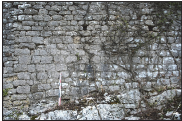
Fig. 94 : Le mur MR 6f de belle facture, présentant deux trous de boulin (à droite) (photo : F. Loppe, 2012).
