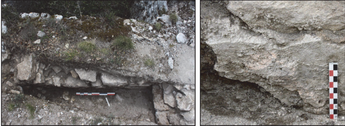
Fig. 26 : Parement interne du mur MR 11 perçu dans la tranchée TR 3b. On notera la présence d'un départ de voûte s'appuyant sur le parement ouest du mur MR 6. À droite, mortier de tuileau rose plaqué contre le mur MR 11. Photos : J.-F. Modat, 2012.
