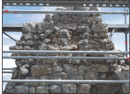
Fig. 71 : La maçonnerie MR 3f occultant les vestiges d'un chemin de ronde (photo : F. Loppe, 2012).
