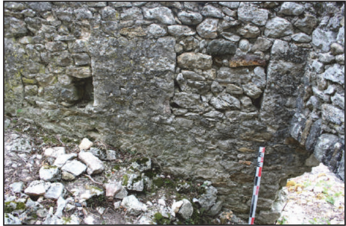
Fig. 102 : MR 7b, reprise en élévation de la partie basse de la barbacane (photo : F. Loppe, 2012).
