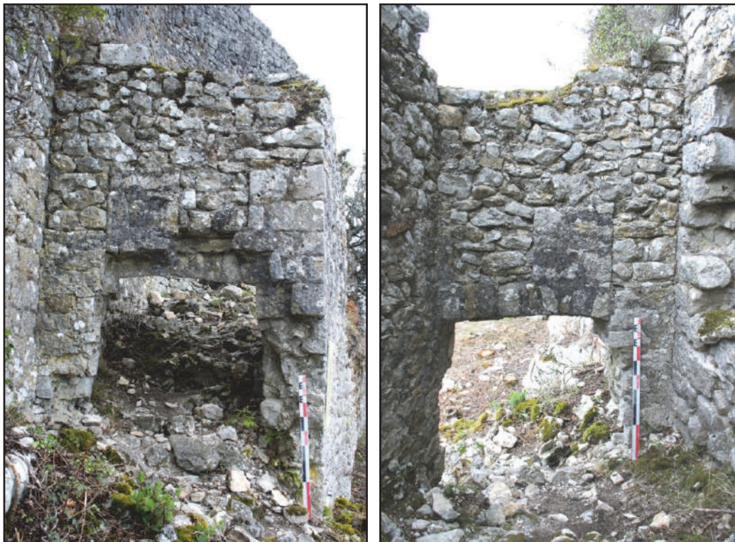
Fig. 103 : La porte P3 de la barbacane s'appuyant sans liaison contre le mur MR 6f (photo : F. Loppe, 2012).
