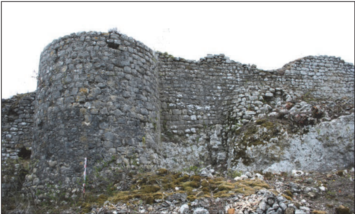
Fig. 99 : Vestige du mur MR 6f au sud de la tour TO 1 (photo : F. Loppe, 2012).
