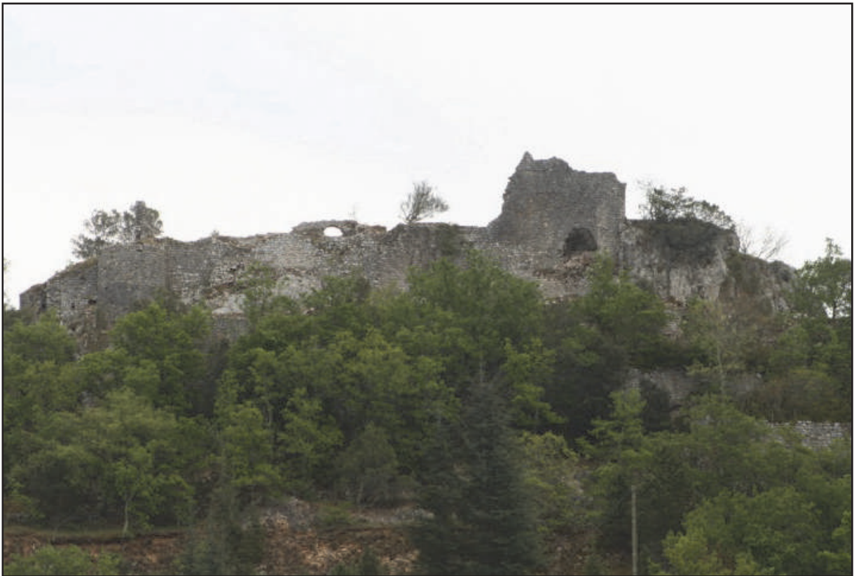
Fig. 85 : Le mur MR 6 vu de l'ouest (photo : F. Loppe, 2012).
