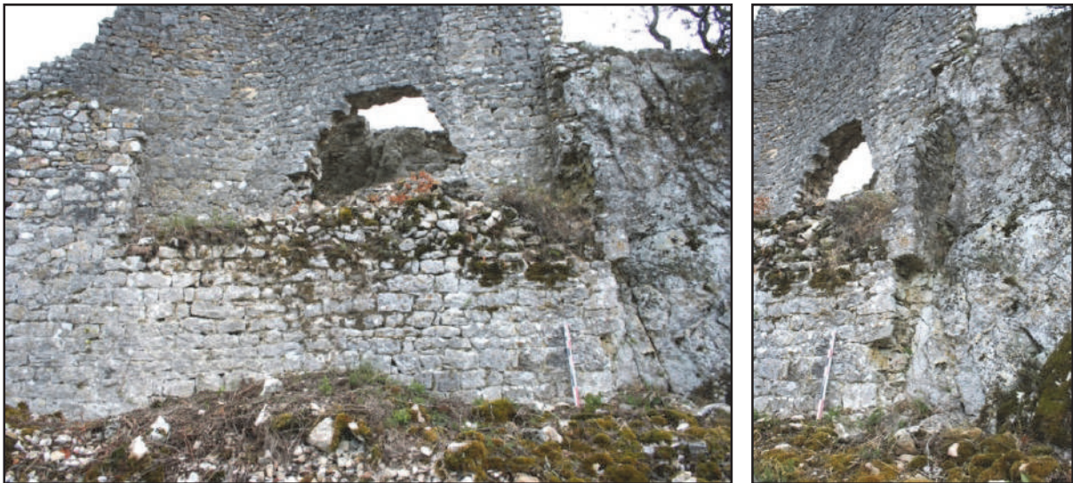
Fig. 101 : Le mur MR 7a constituant la base du mur MR 7 (photo : F. Loppe, 2012).
