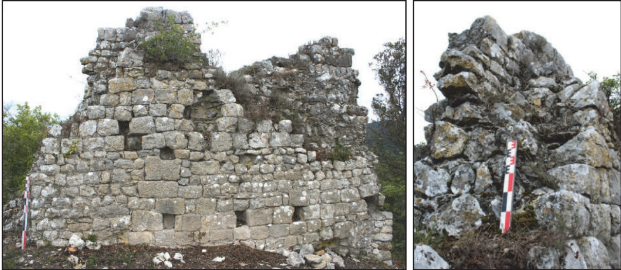
Fig. 69 : Parement interne de MR 3 (à gauche) et vestige de chemin de ronde (à droite) (photos : F. Loppe, 2012).
