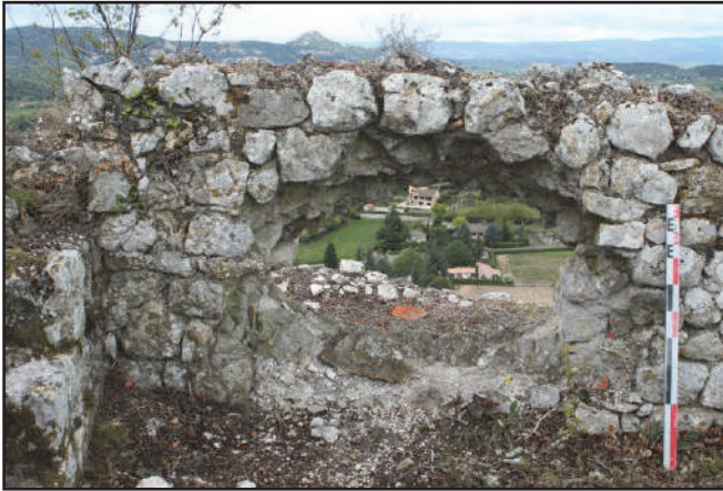
Fig. 81 : Maçonnerie MR 4c correspondant à un bouchage du mur MR 4b réalisé avec des blocs de récupération (photo : F. Loppe, 2012).
