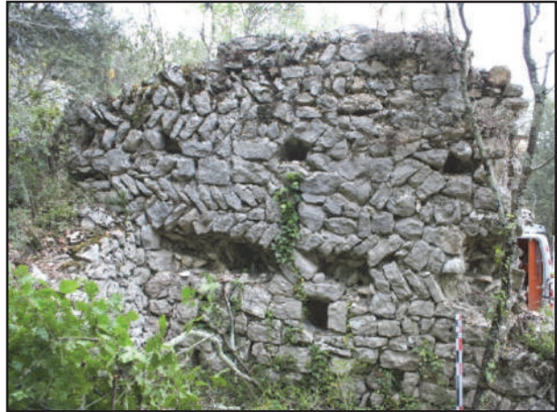
Fig. 111 : Le parement ouest du mur MR 10 (photo : F. Loppe, 2012).
