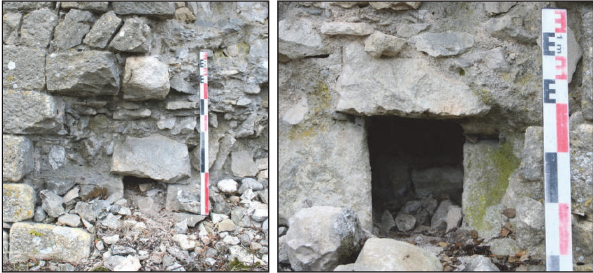
Fig. 66 : Les archères A1 (à gauche) et A2 (à droite) visibles sur le mur MR 3a (photo : F. Loppe, 2012).
