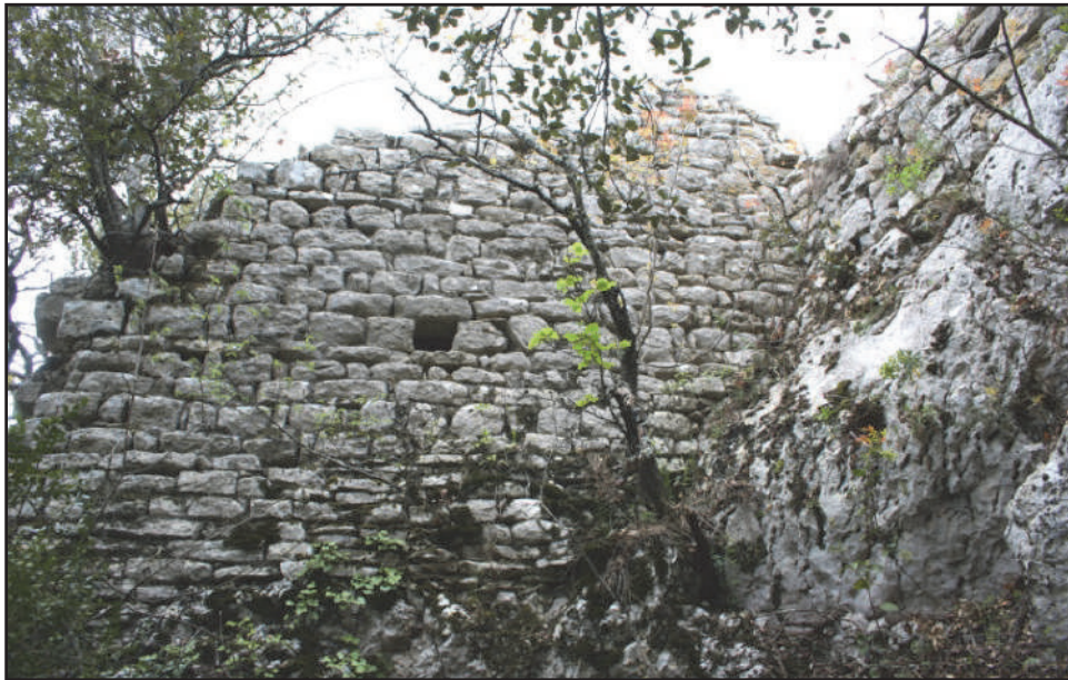
Fig. 105 : Le mur MR 5a vu du nord, composé de moellons calcaires équarris et présence d'un trou de boulin (photo : F. Loppe, 2012).
