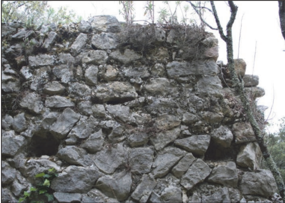
Fig. 116 : Assises horizontales des parements de la maçonnerie MR 10b (photo : F. Loppe, 2012).
