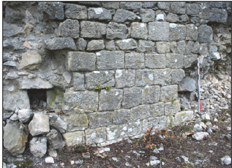
Fig. 64 : Le mur MR 3a dont les parements sont composés de moellons calcaires très bien équarris (photo : F. Loppe, 2012).
