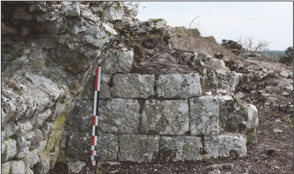
Fig. 121 : Arase conservée de la tour-maîtresse. Parement nord en moyen et grand appareil calcaire, vraisemblablement datable des XII e -XIII e siècles (photo : J.-F. Modat, 2012).
