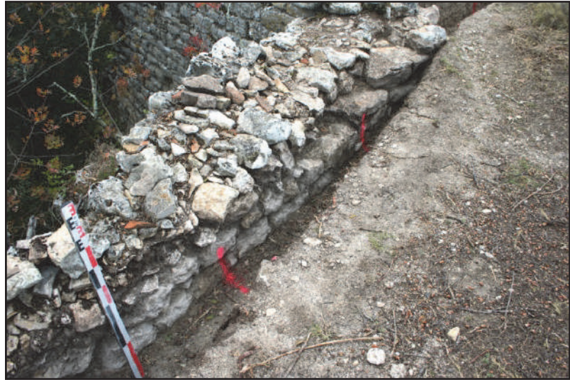
Fig. 107 : Le mur MR 5d en partie masqué par un muret en pierres sèches (photo : F. Loppe, 2012).
