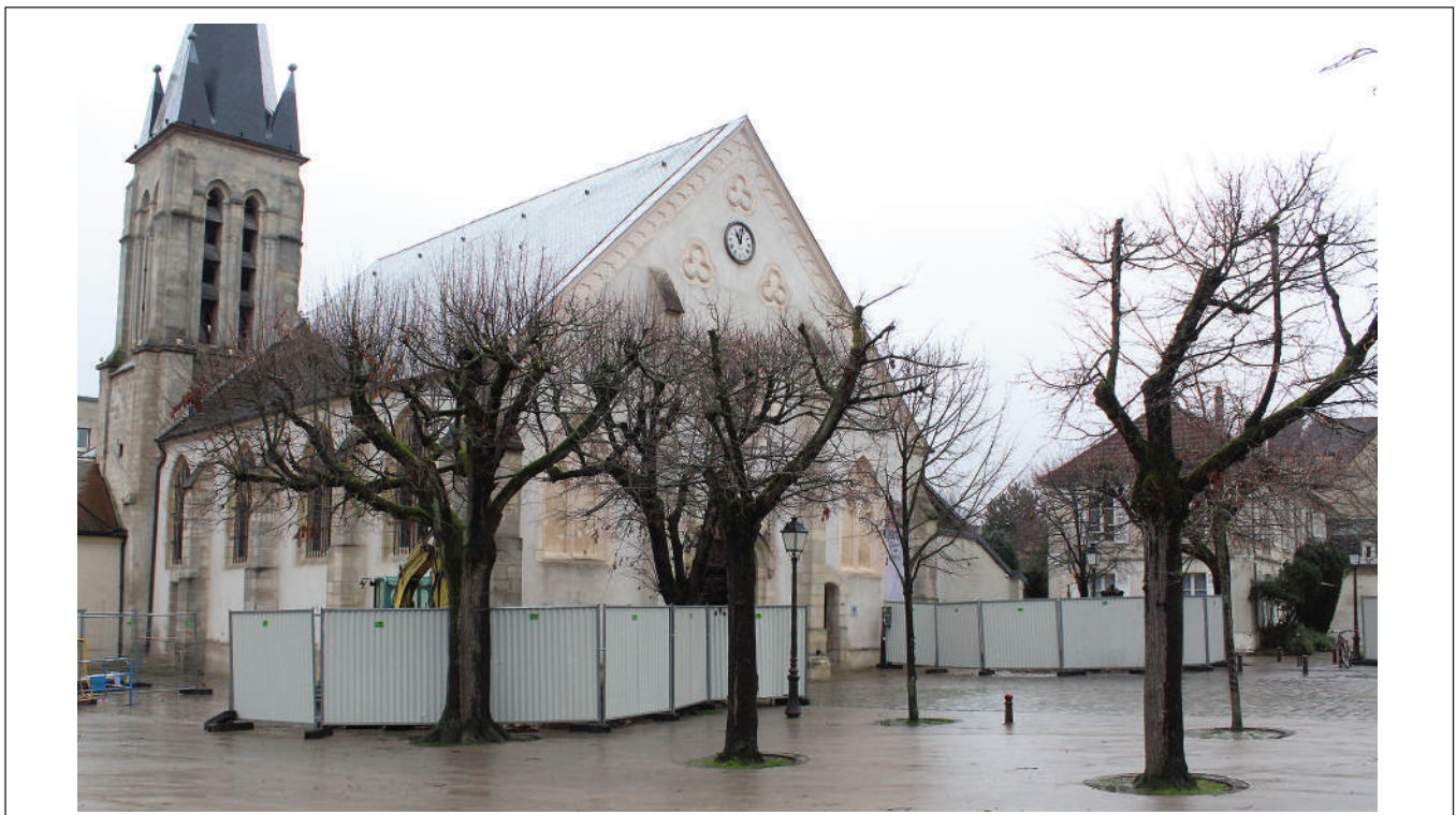
Fig. 13 : vue des espaces diagnostiqués sécurisés à l'aide des clôtures opaques mobiles.
