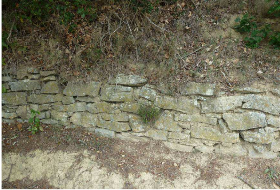
Fig. 146 : Muret en pierres sèches bordant l'ancien chemin de Carcassonne à Lagrasse.
