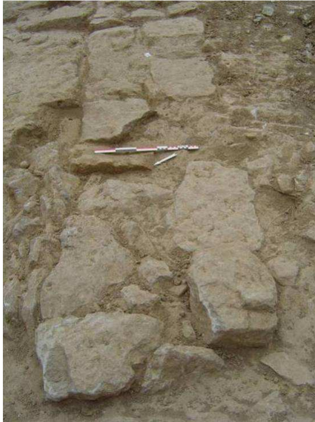
Fig. 66 : Le mur MR 01.266, vu du nord-ouest
