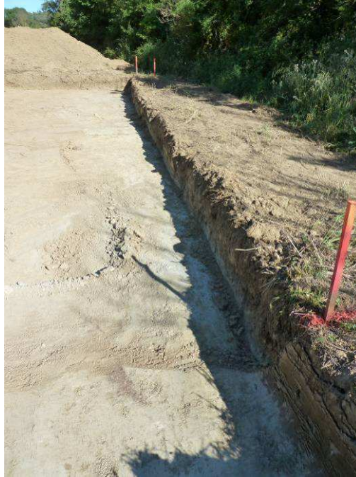
Fig. 90 : L'US 01.311 le long de la berme sud. Vu de l'ouest
