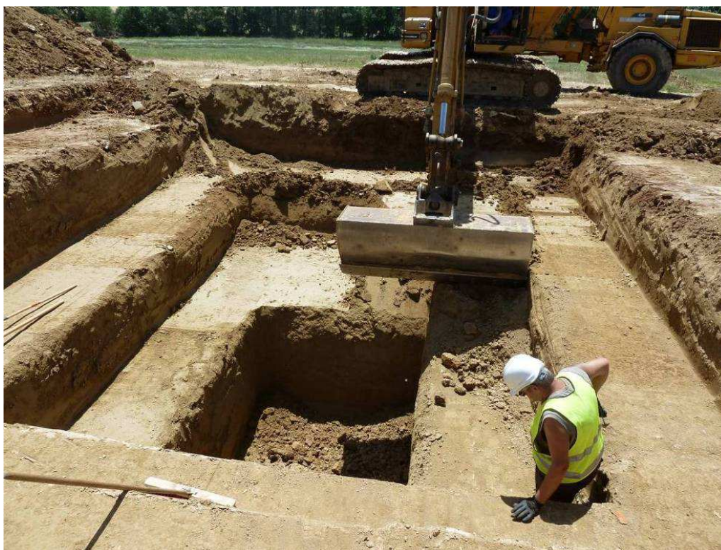
Fig. 152 : Creusement du sondage géologique SG 1.
