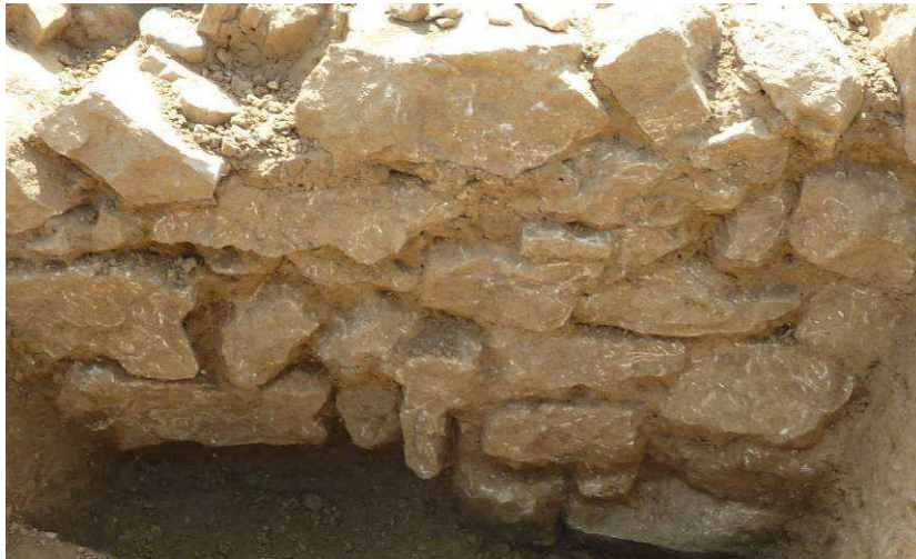
Fig.131 : MR 02.209 : appareil en moellons assisés (vu du nord).
