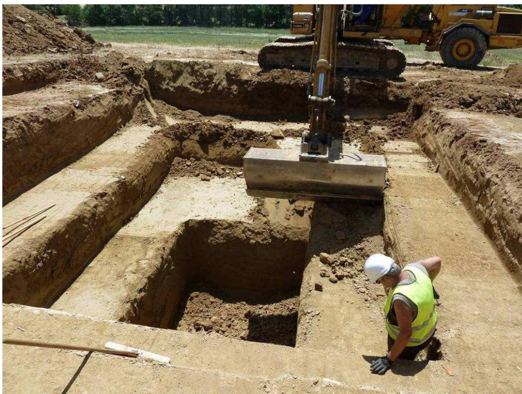
*Fig. 152 : Creusement du sondage géologique SG 1.*
