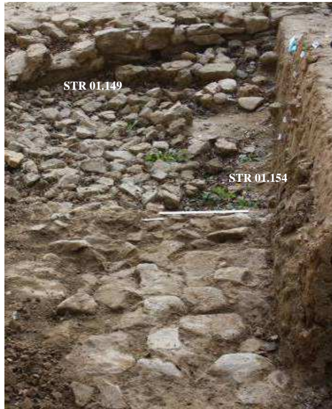
Fig. 38 : La structure STR 01.154 en lien avec la structure STR 01.149. Vu de l'ouest
