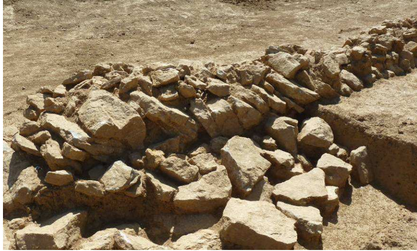
Fig.130 : MR 02.209 : appareil en opus spicatum (vu du nord).
