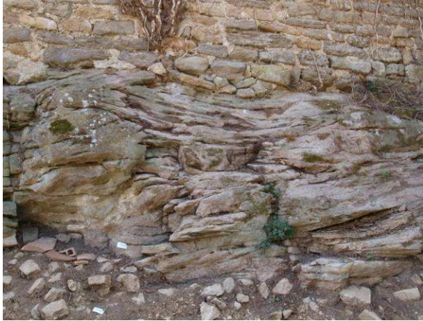
Fig. 460 : Photo 1 : banc de grès à stratifications entrecroisées constituant l'assise du pigeonier
