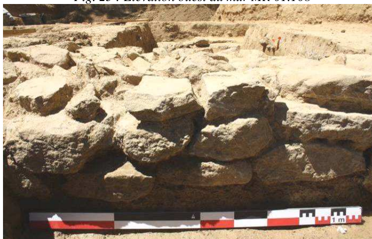
Fig. 26 : Le MR 01.108, détail de l'élévation. Vu de l'est
