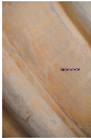
Arcade ouest ouvrant sur le transept, face ouest, motif fantaisiste de l'UE 2
