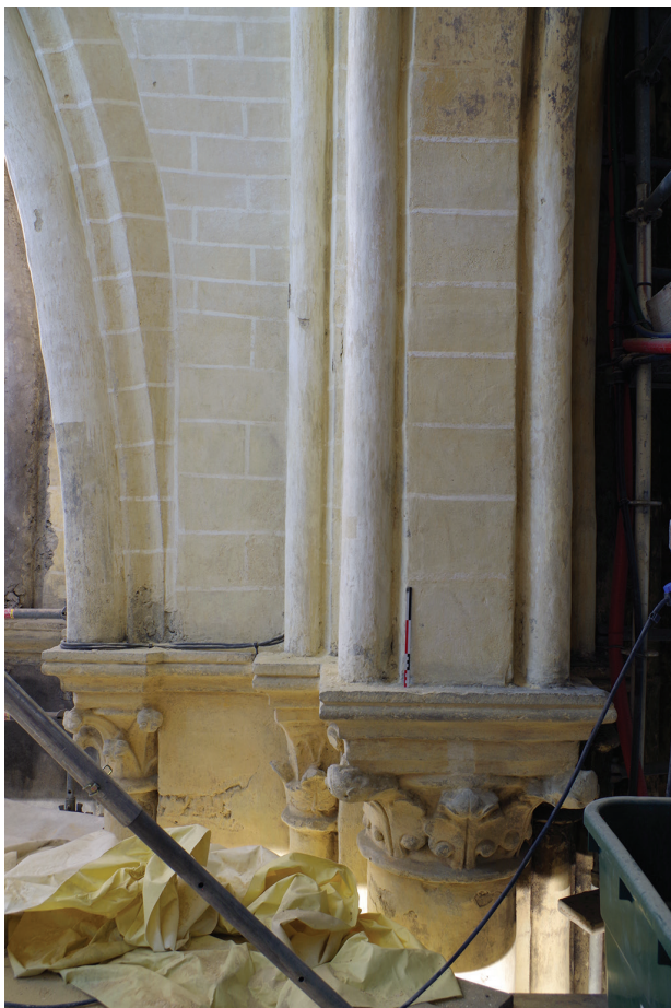
fig. 29 : Pilier 1, décor de faux-appareil à l'intrados de l'arcade : irrégularité de la hauteur du sommier par rapport aux claveaux de l'arc.
