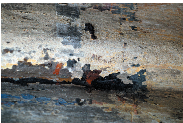
fig. 58 : Ogive SUD-EST, face OUEST : la polychromie recouvre le badigeon orange de UE 2.
