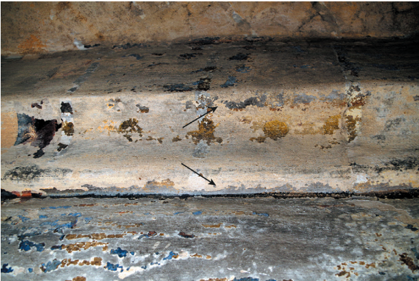
fig. 67 : Doucine de l'ogive SUD-EST, des bandes grises peu conservées longent le tore (en bas) et l'arête de la face verticale (en haut).
