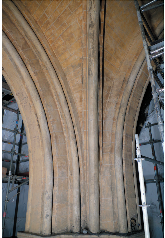
fig. 39 : Retombée de la voûte au NORD-EST, décor UE 2 : les surfaces planes et en creux reçoivent le faux-appareil ; les tores sont blancs.
