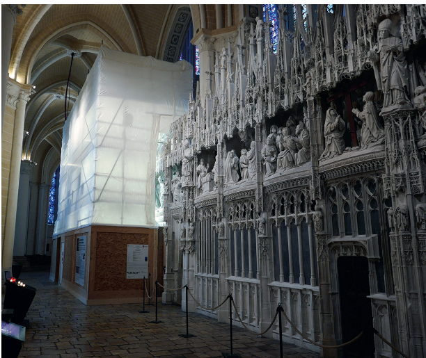
fig. 1 : Tour de chœur en cours de restauration, partie NORD.
