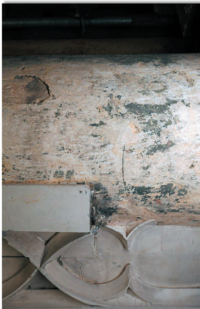
Pilier 1, colonne engagée nord : vestiges de polychromie antérieure au tour de chœur
