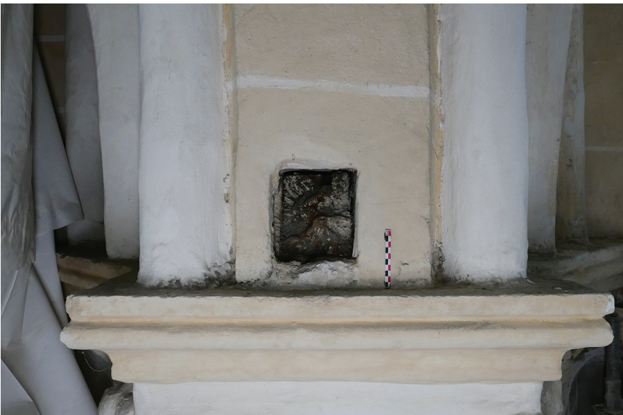
fig. 23 : Pilier P 2, vestige d'un ancrage et d'une poutre en bois dans la retombée de l'arc doubleau NORD. Semelle maçonnée pour rehausser la poutre.
