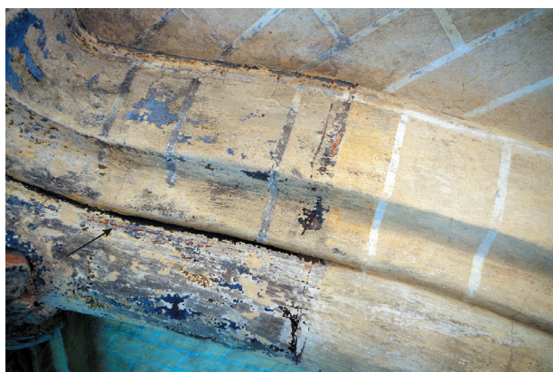
fig. 60 : Ogive NORD-OUEST, face NORD, incision verticale sur toute la hauteur de l'ogive et tracé préparatoire rouge sur le torse.
