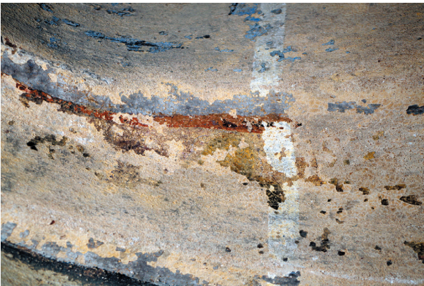
fig. 68 : Doucine de l'ogive NORD-EST, face EST, la feuille d'or est recouverte d'une couche rose qui semble dessiner des motifs.
