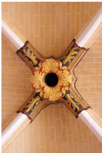
Travée 1 sud du premier déambulatoire, après restauration
