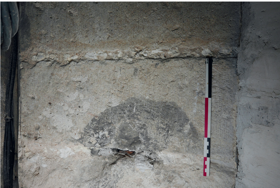
fig. 5 : Pilier P4, face nord-ouest du fût, cales en calcaire crayeux dans les joints.
