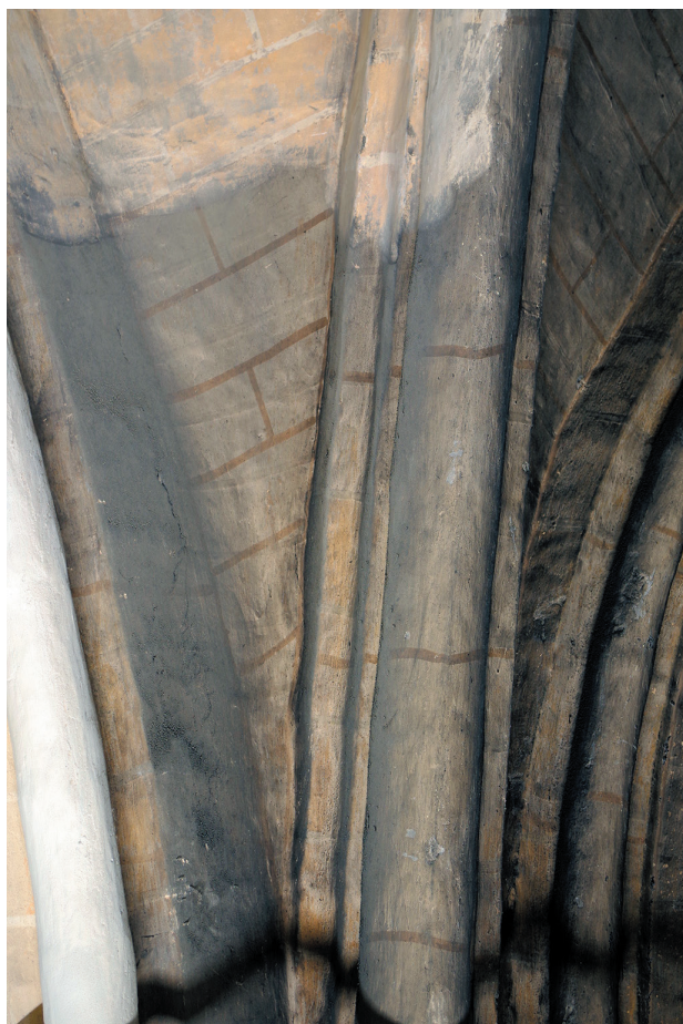
fig. 48 : Retombée SUD-EST de la voûte, décor de faux-joints rouge UE 3 en continu sur les quartiers de voûte et sur les moulures des arcs.
