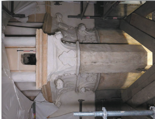
Pile 3, vue d'ensemble depuis le nord après dépeussilage
