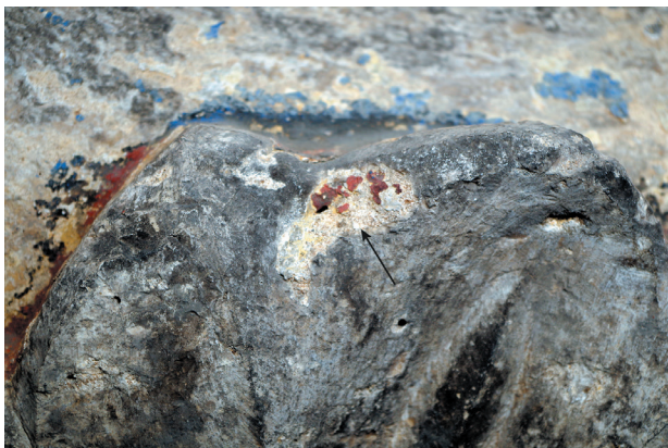
fig. 56 : Détail d'une feuille de la clef : l'enduit UE 1 est appliqué dans un trou de la pierre, il est recouvert par les couches polychromes de l'UE 17.
