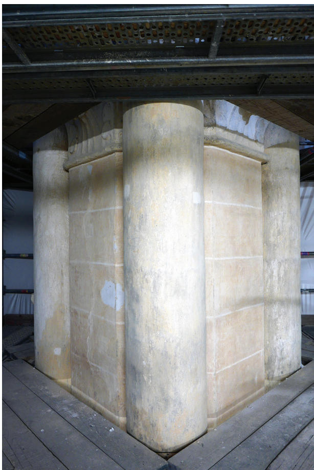
fig. 30 : Pilier 1a, décor de faux-appareil UE 1 : faux-joints horizontaux seulement.
