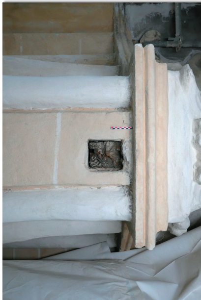
Pilier 2, face nord : trou d'ancrage avec pièce de bois scellée dans le mortier de construction
