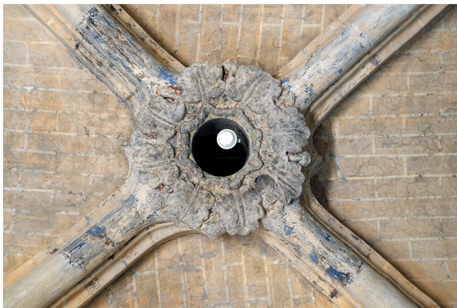
fig. 54 : Vue d'ensemble de la clef de voûte.
