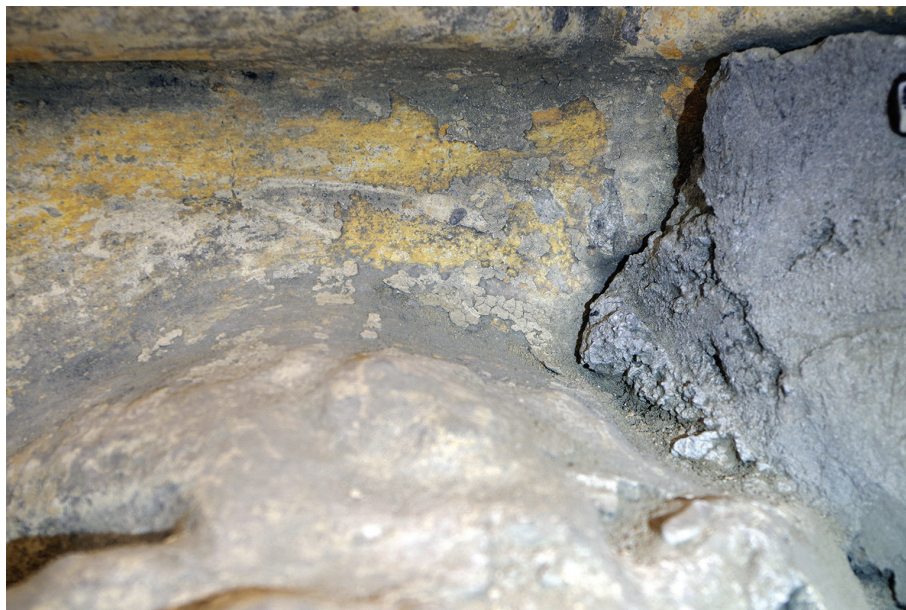
fig. 53 : Chapiteau du pilier P 2 : le badigeon UE 3 beige-rose, gras à la texture grumeleuse, est recouvert par la maçonnerie grise du décor de V. Louis.
