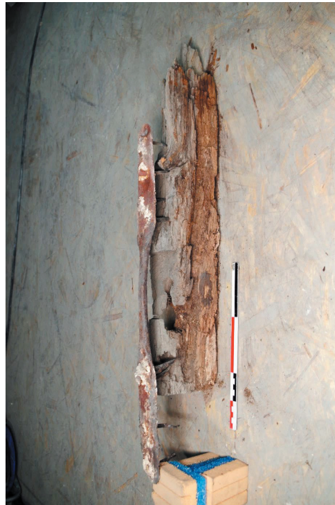
Pièce de bois et fixation métallique, après dépose (face nord).
