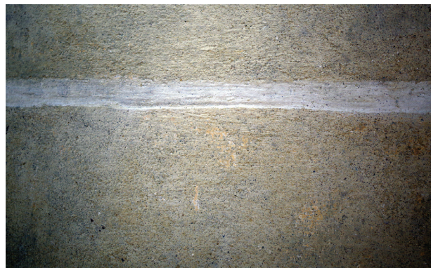
fig. 26 : Détail d'un faux-joint horizontal de l'enduit UE et de la texture épaisse du badigeon blanc.
