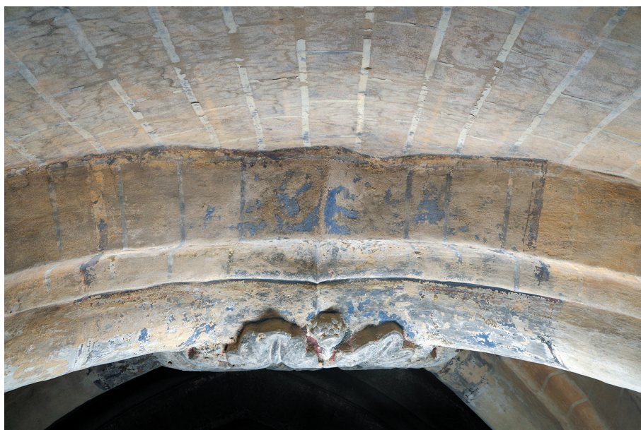
fig. 55 : Vue d'ensemble de la clef de voûte depuis le NORD, jonction en accolade des ogives.
