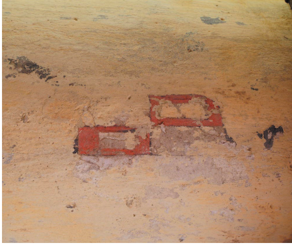
Colonne engagée ouest de la pile 1a : écu peint sur une matière fibreuse
