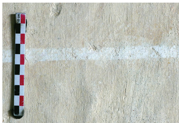
fig. 25 : Pilier 1a, aspect de l'enduit UE 1 sur la face SUD-OUEST du noyau.
