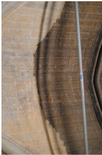
Voûtain sud en cours de décausséage. L'UE 3 (couche brune en bas) recouvre l'UE 2 (faux-joints blanc sur badigeon rose-orange en haut).
