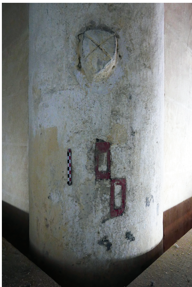
fig. 86 : Élévation OUEST du pilier P 1a, colonne engagée, écu peint (UE 18) surmonté d'un écu fiché dans la colonne et en saillie.
