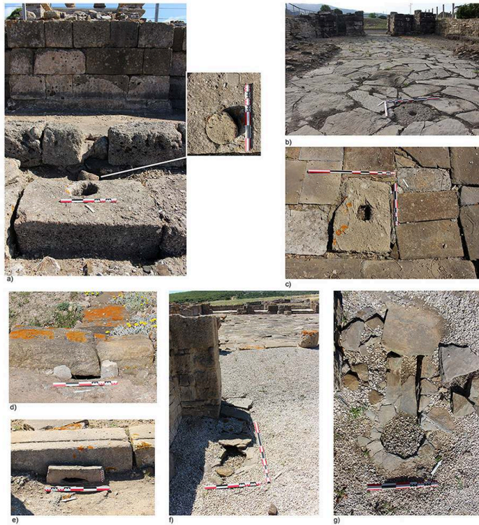
Fig. 8. a) Regard de l'égout de la fontaine monumentale [St 9] ; b) Hypothétique regard d'égout dans le decumanus (tronçon est) [St 25] ; c) Hypothétique regard d'égout sur le forum [St 8] ; d) Bouche d'égout ouest du macellum [St 3] ; e) Bouche d'égout est du macellum [St 4] ; f) Petit regard d'égout dans la boutique B4 du forum [St 10] ; g) Petit regard d'égout dans la boutique B1 du forum [St 12].
