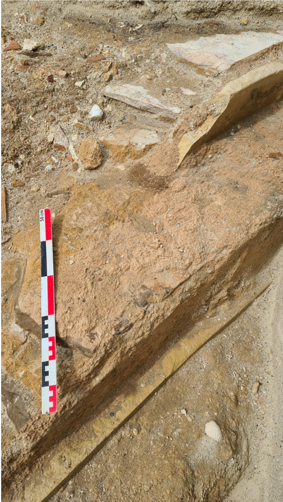
Détails des maçonneries de l'escalier de la piscine rectangulaire © Spiesser - Caux Seine Agglo
