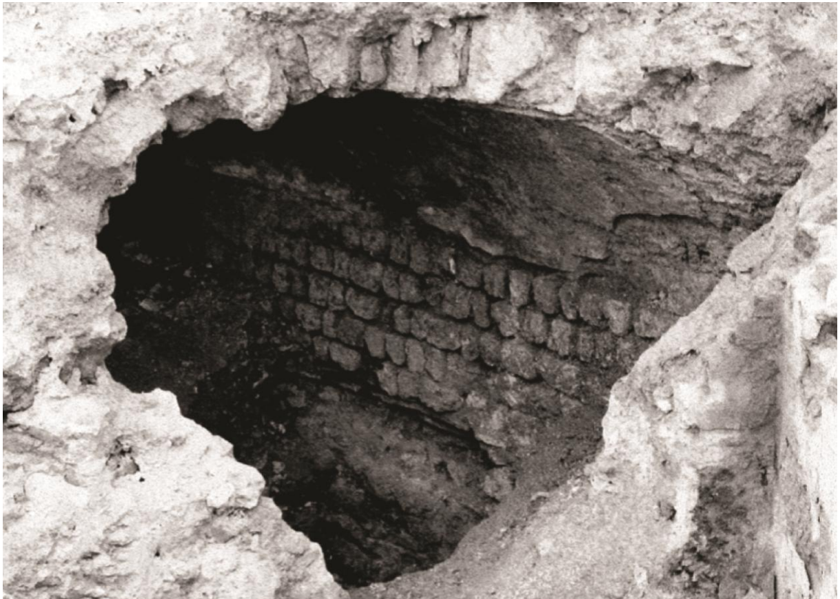
Photographie de la galerie de service © Pitte 1985
