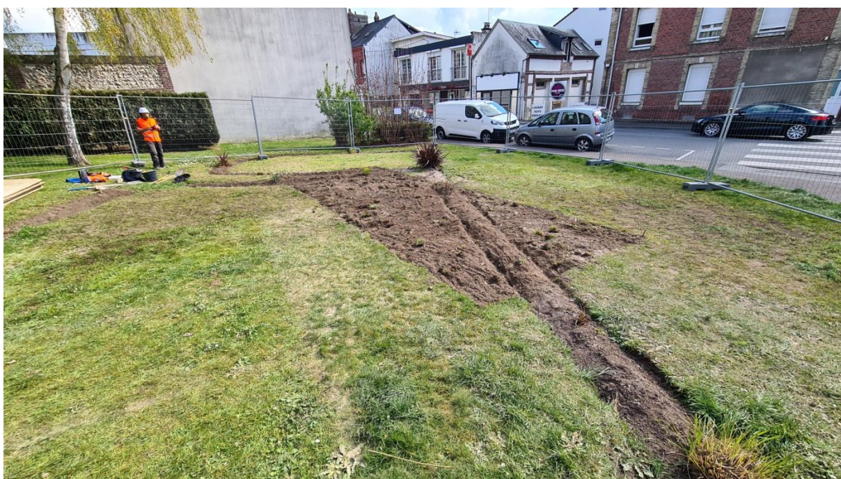
Photographie du site après le rebouchage manuel © Spiesser – Caux Seine Agglo
